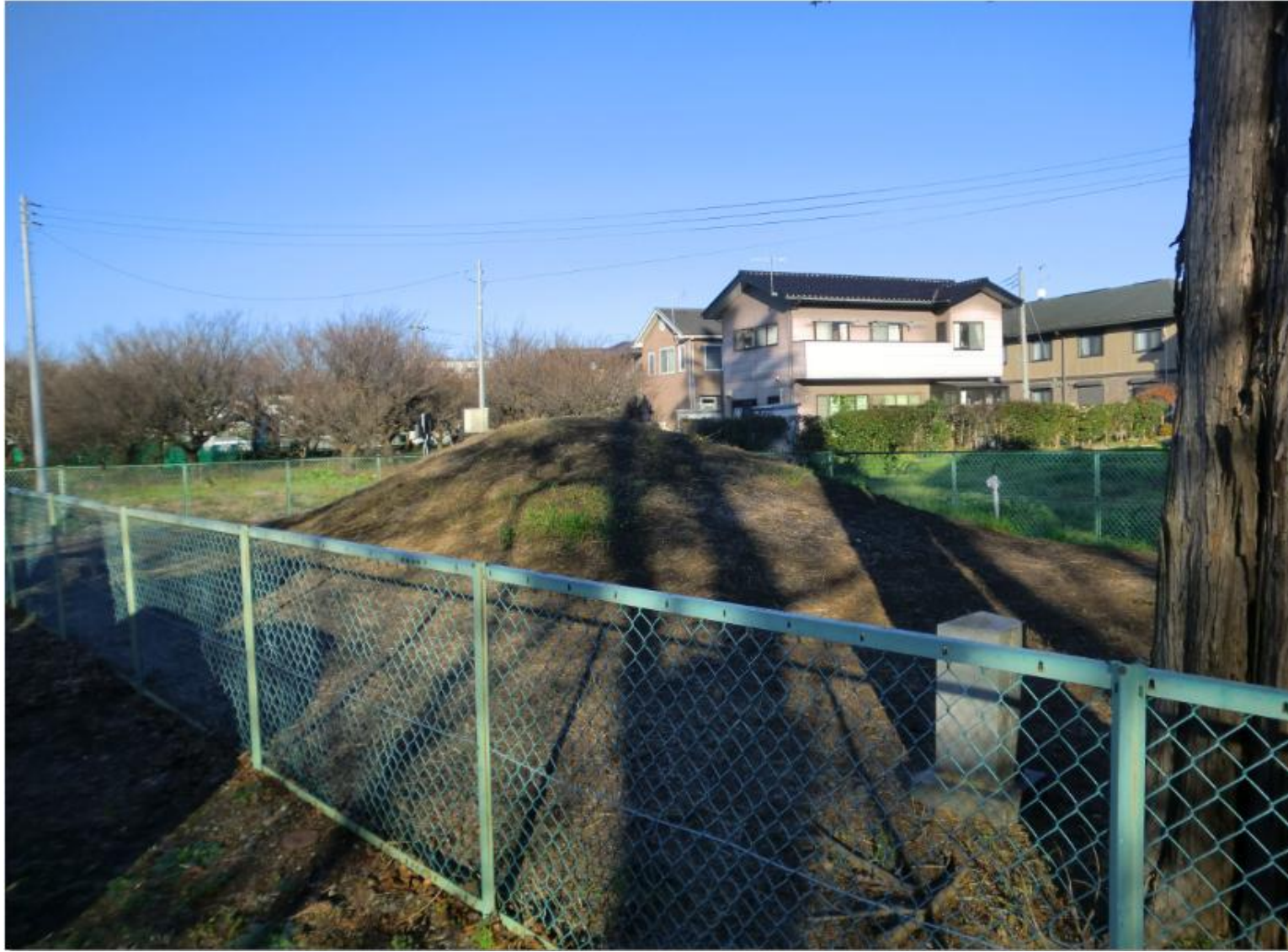
南西側から見たところ
