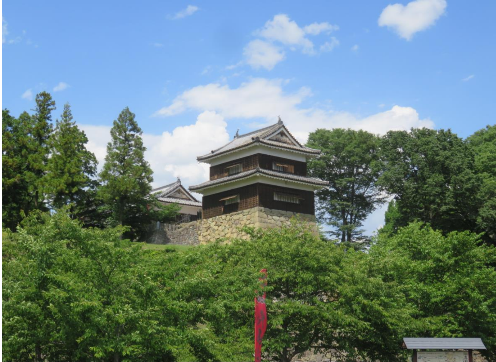
アップで見たところ/左奥の屋根は東虎口櫓門
