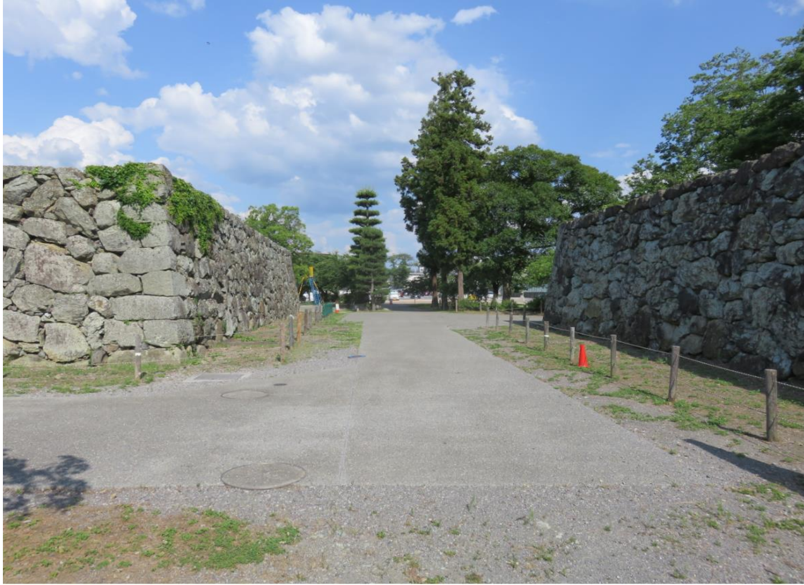
二の丸北虎口を西側から東方向に見たところ
