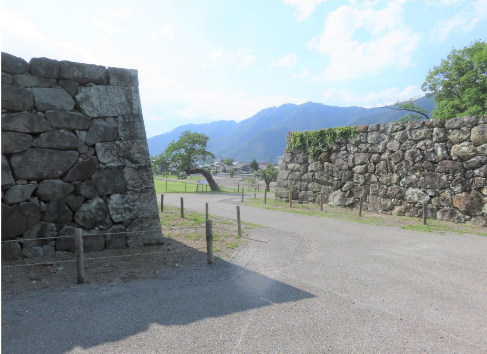
左手から柵形虎口を見たところ
