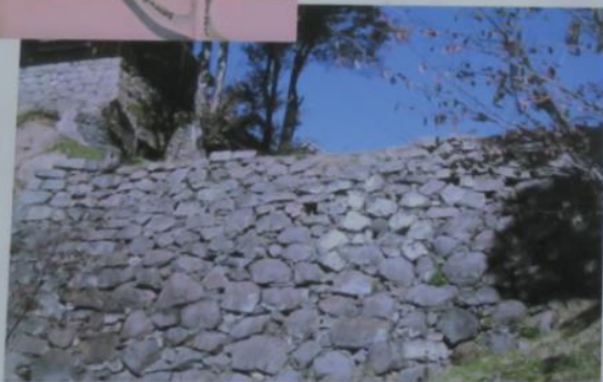
本丸堀の東南隅の石垣(中央に排水口)
