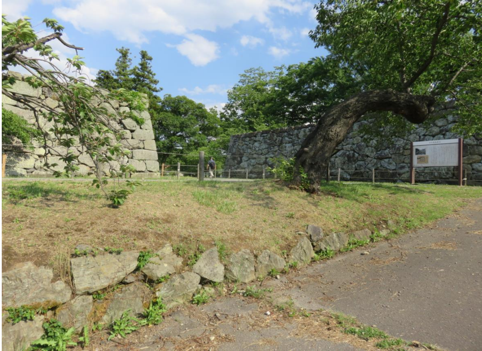
その坂を戻って柵形虎口を見たところ
