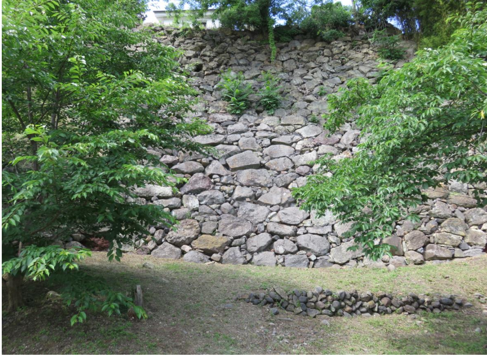
野面積みの石垣を見たところ
