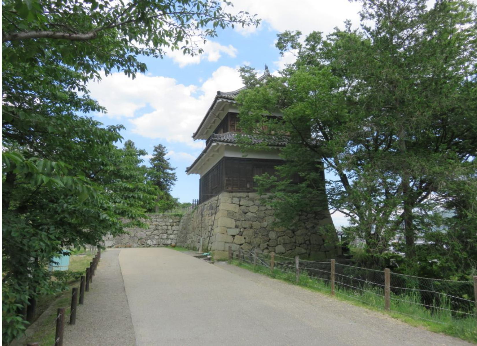
本丸西虎口と西櫓/手前は二の丸から本丸西虎口への土橋
