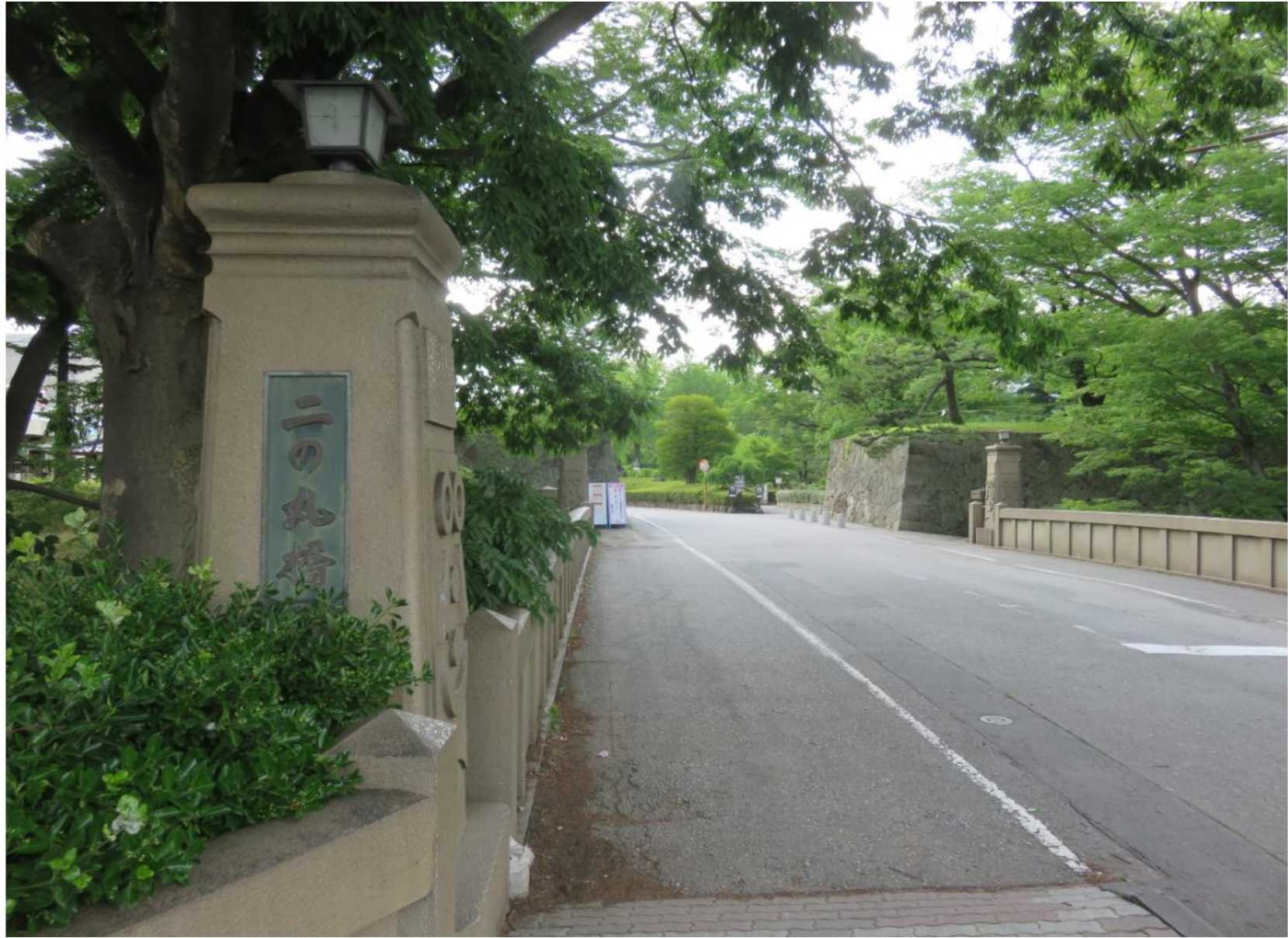
欄干に「二の丸橋」と記されている
