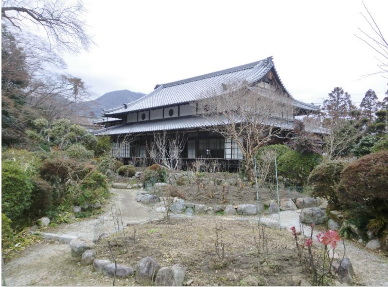
南東側から見る
