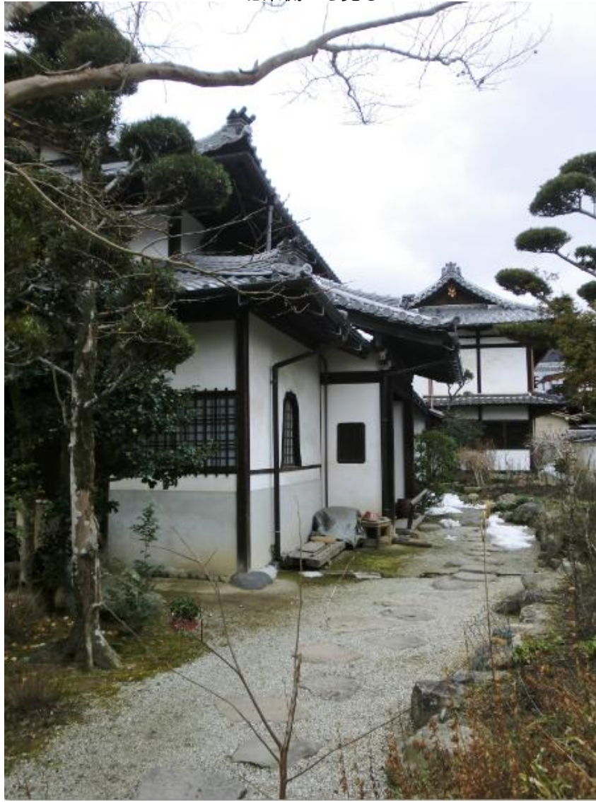
北東側から見る
