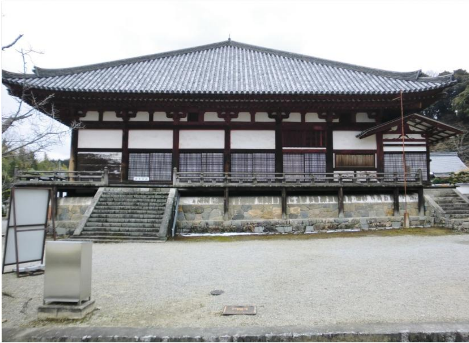
北側から見る
