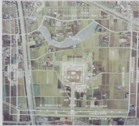
志波城跡全景写真 (2003年撮影)
