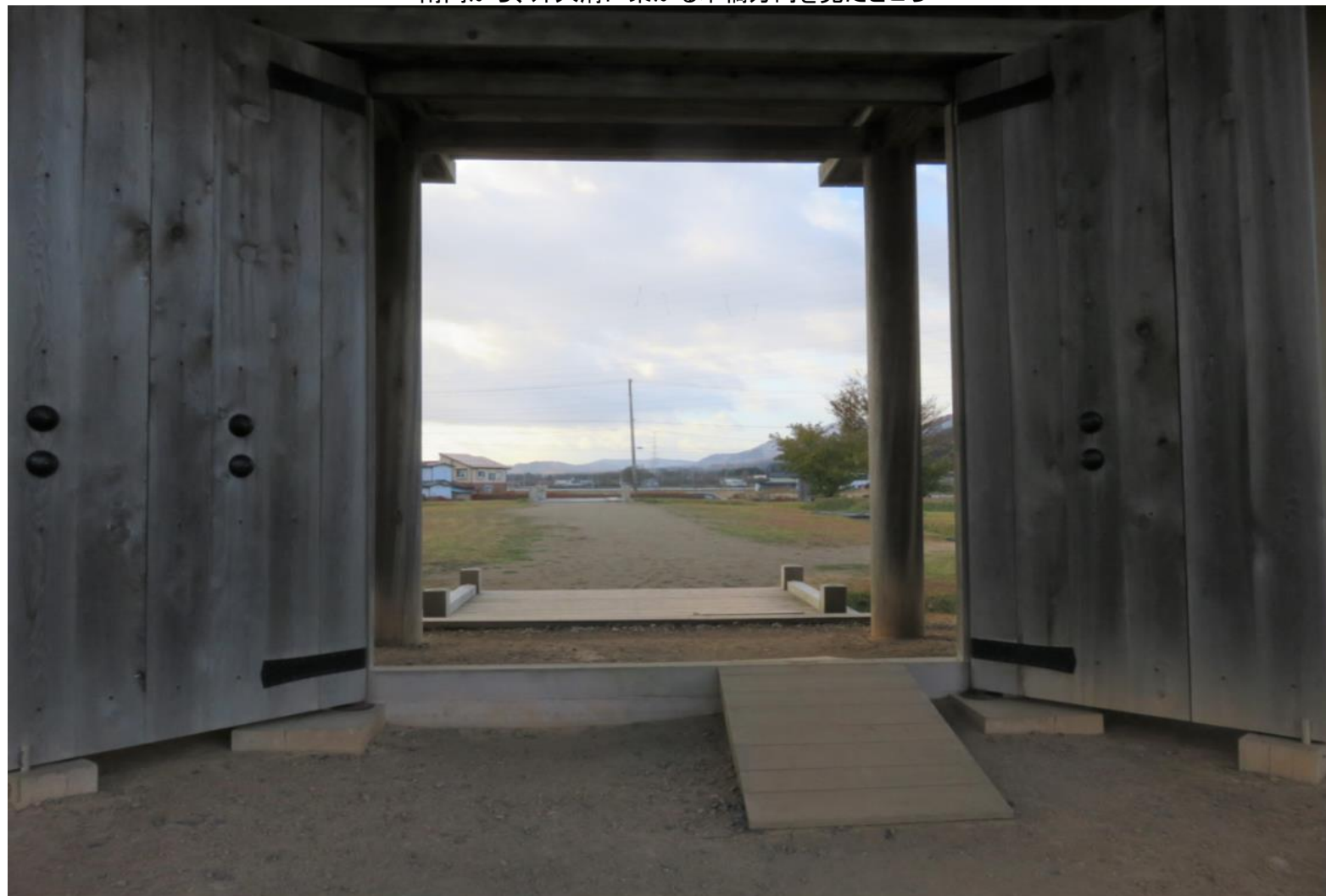
南門から、外大溝に架かる木橋方向を見たところ
