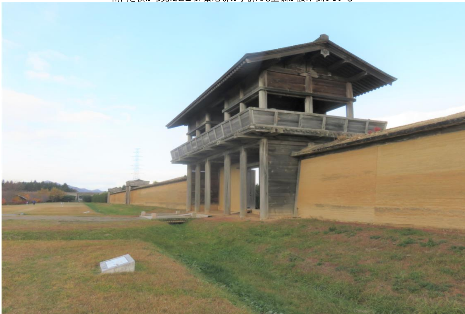
南門を横から見たところ/築地塀の手前にも空堀が設けられている
