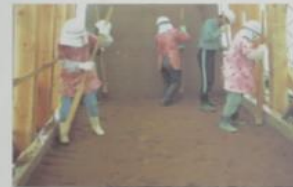
築地塀の版築つき固め作業
