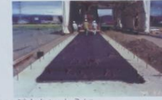
重い築地塀で遺構をつぶさないように、基礎に発泡スチロールの軽量盛土材を敷き詰めました。
