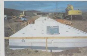
遺構の保護（軽量盛土材の利用）
