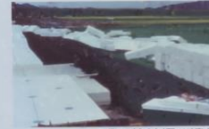
重い築地塀で遺構をつぶさないように、基礎に発泡スチロールの軽量盛土材を敷き詰めました。
