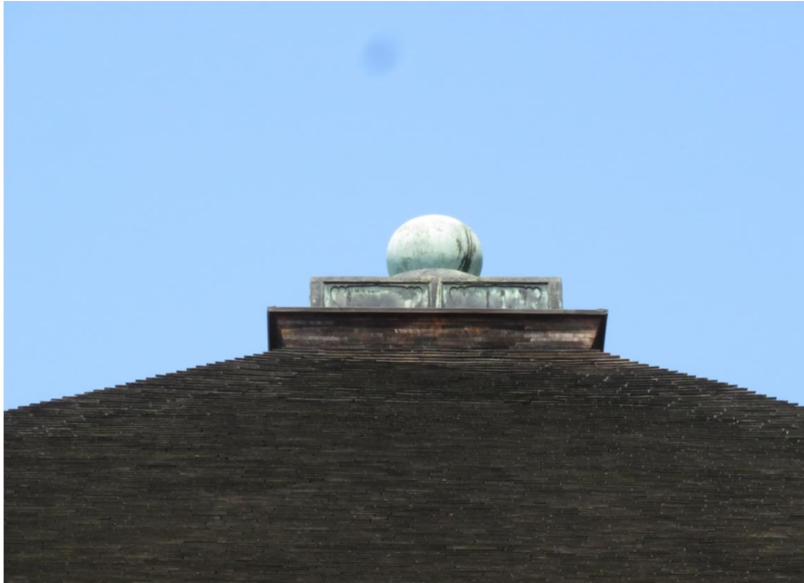
翺(とち)葺屋根に載る宝珠・露盤
