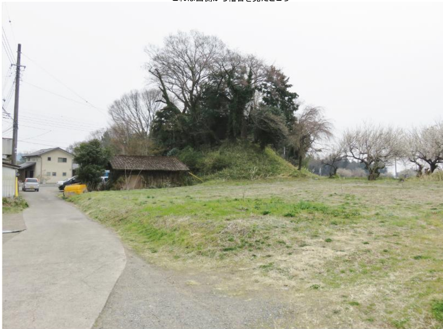
これは西側から櫓台を見たところ
