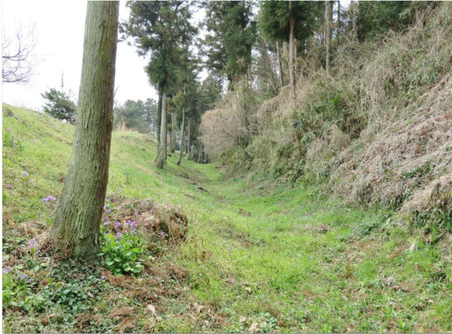
その空堀の堀底に下りて南方向を見たところ
