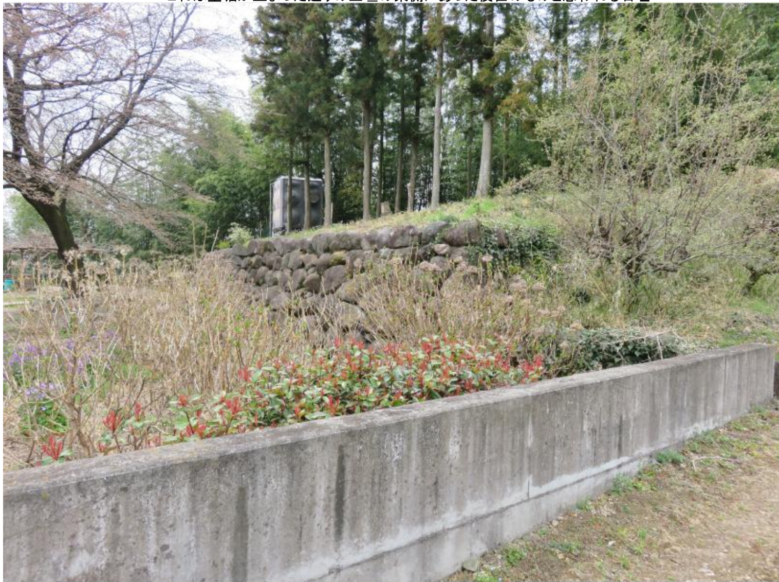
これは空堀が止まった辺りの土壇の東側にあった後世のものと思われる石垣
