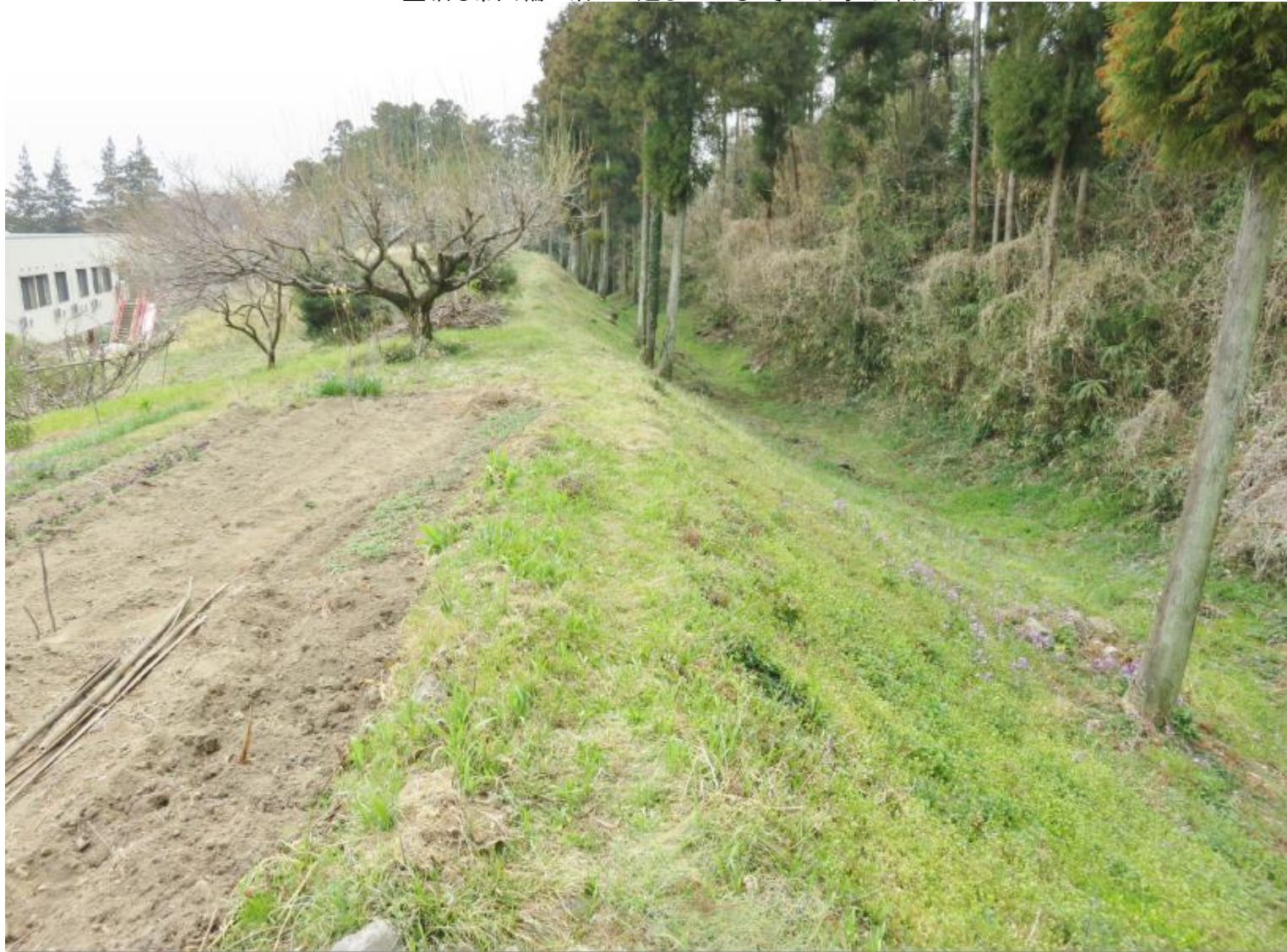
空堀も帯曲輪に沿って延びている/その右手は本丸
