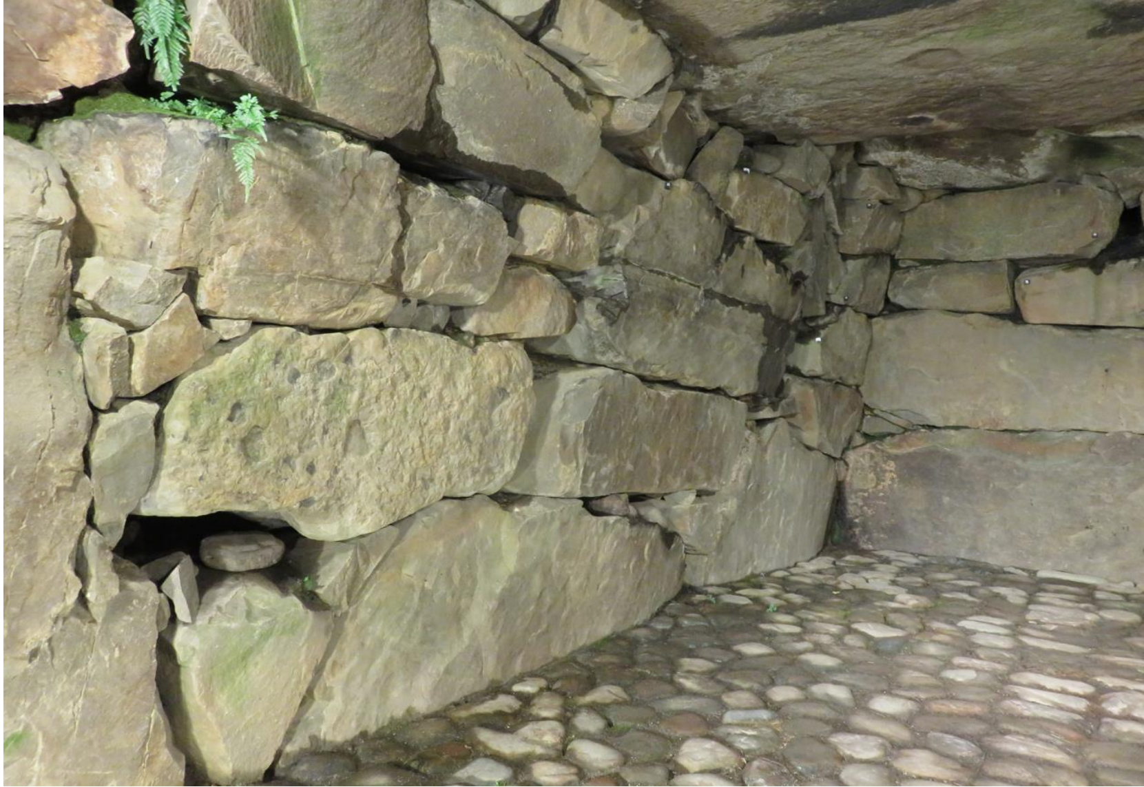
左側面を見たところ
