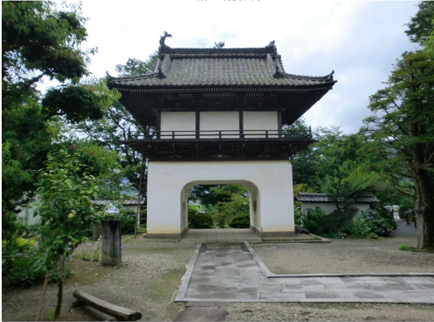
背面から見る山門
