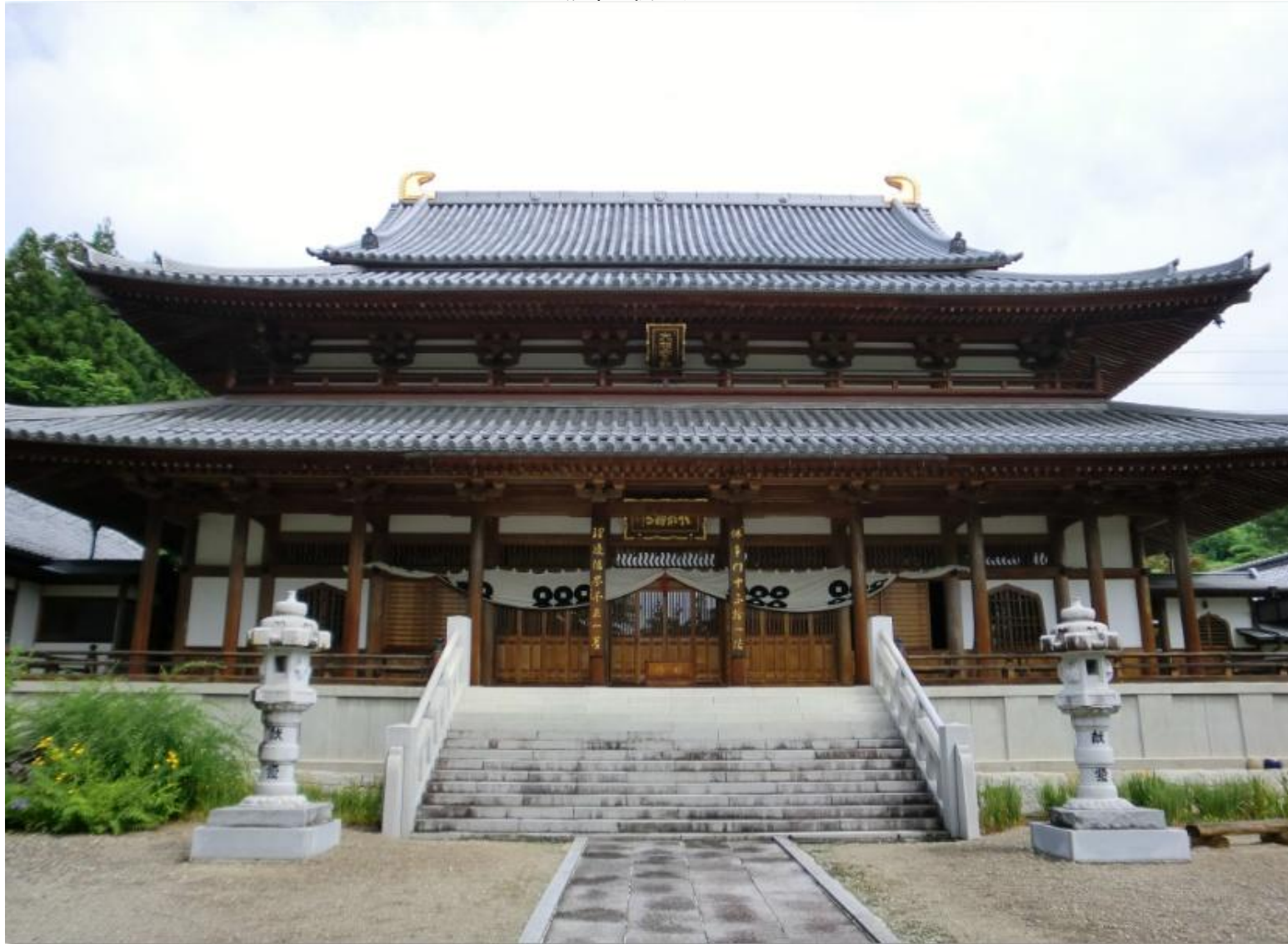
鍔葺屋根となっている
