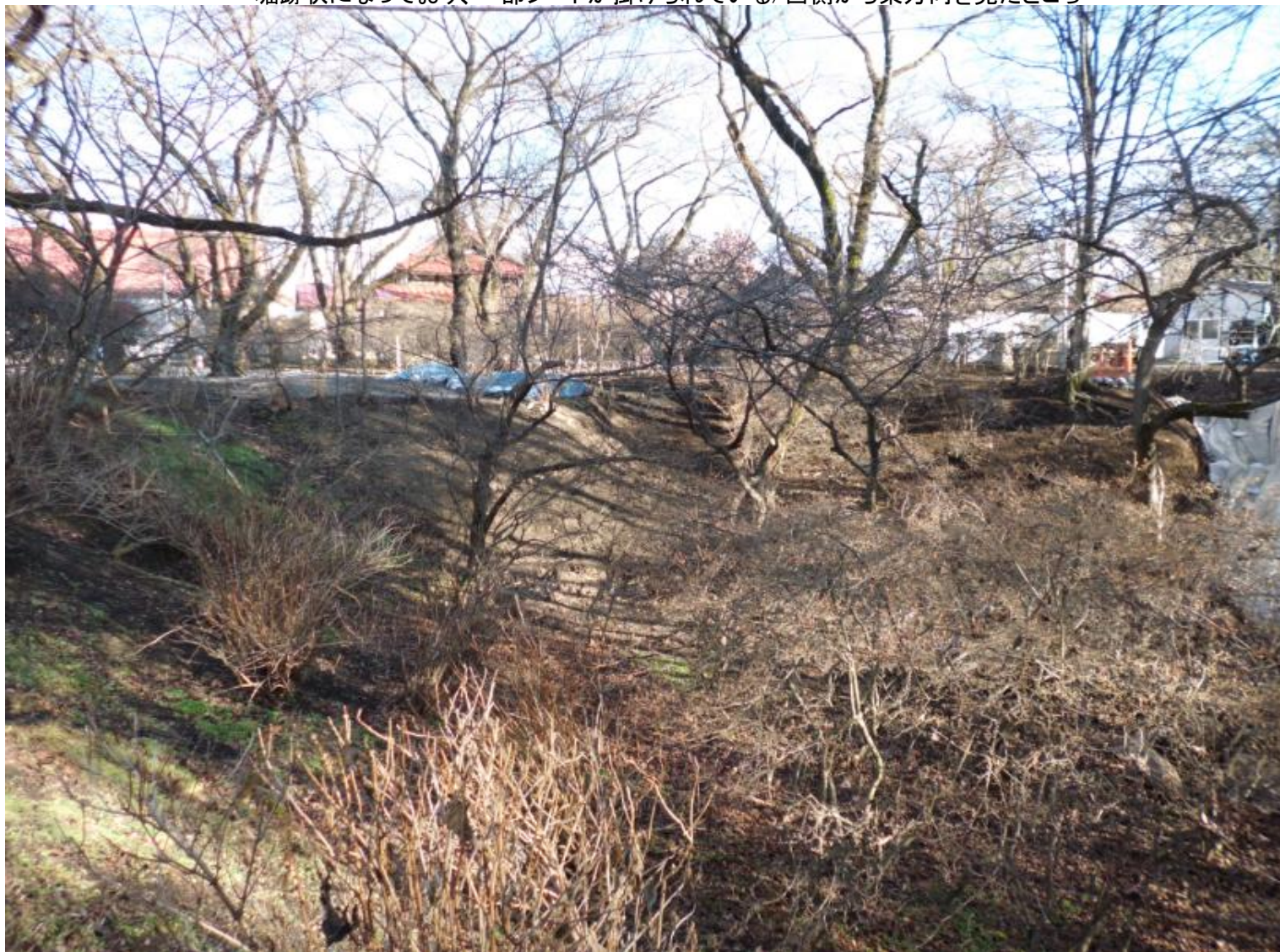
堀跡状になっており、一部シートが掛けられている/西側から東方向を見たところ
