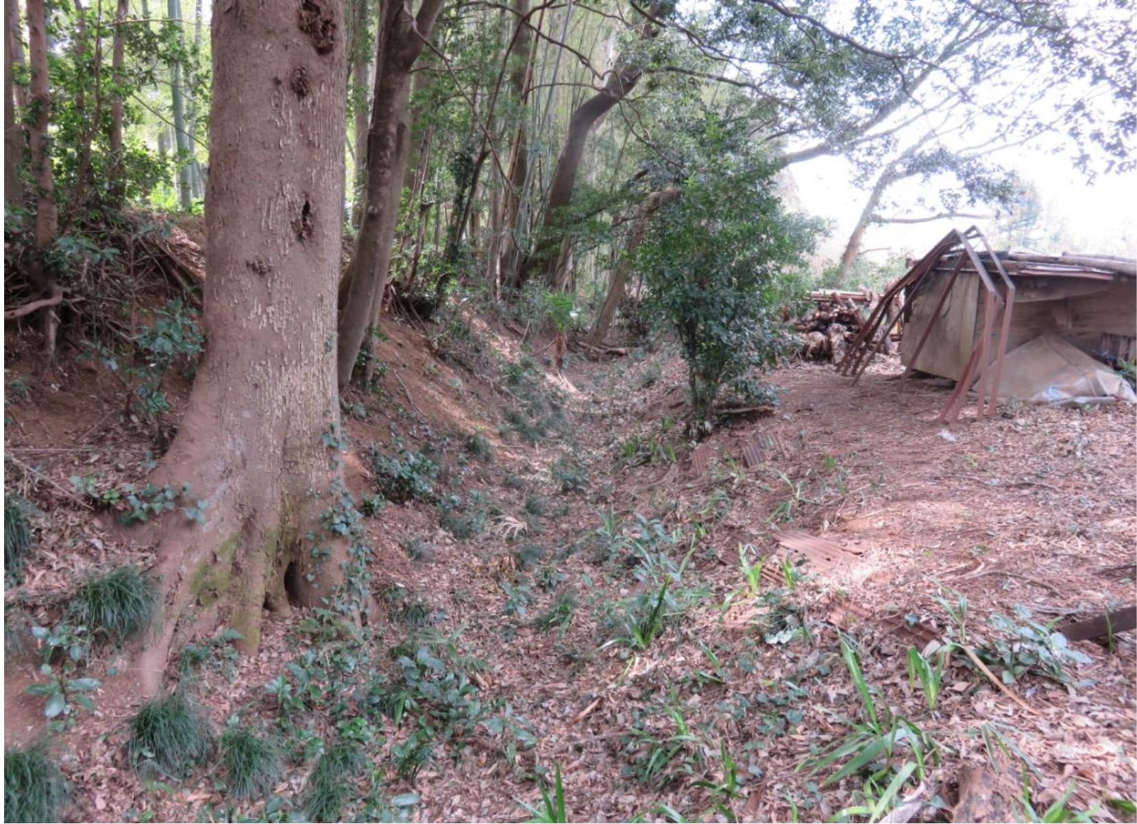
右手の西方向に延びる空堀を見たところ
