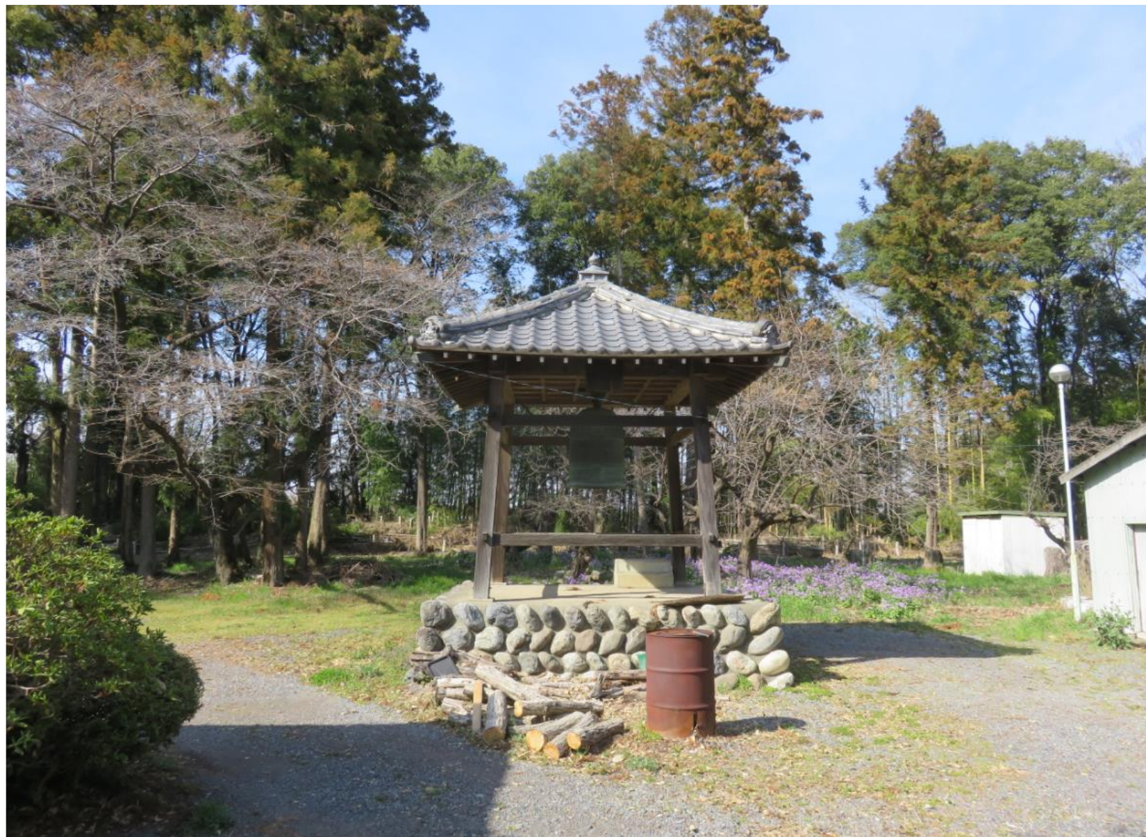
これが南側から見た鐘楼
