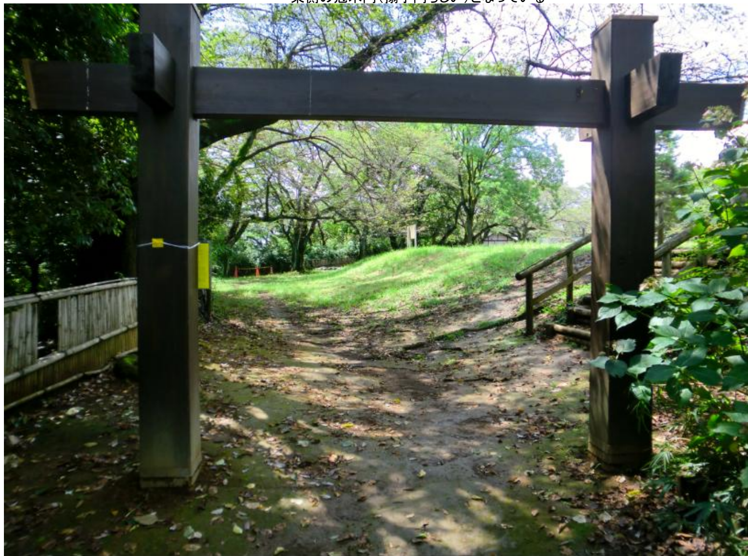
東側の冠木門(搦手門らしい)となっている
