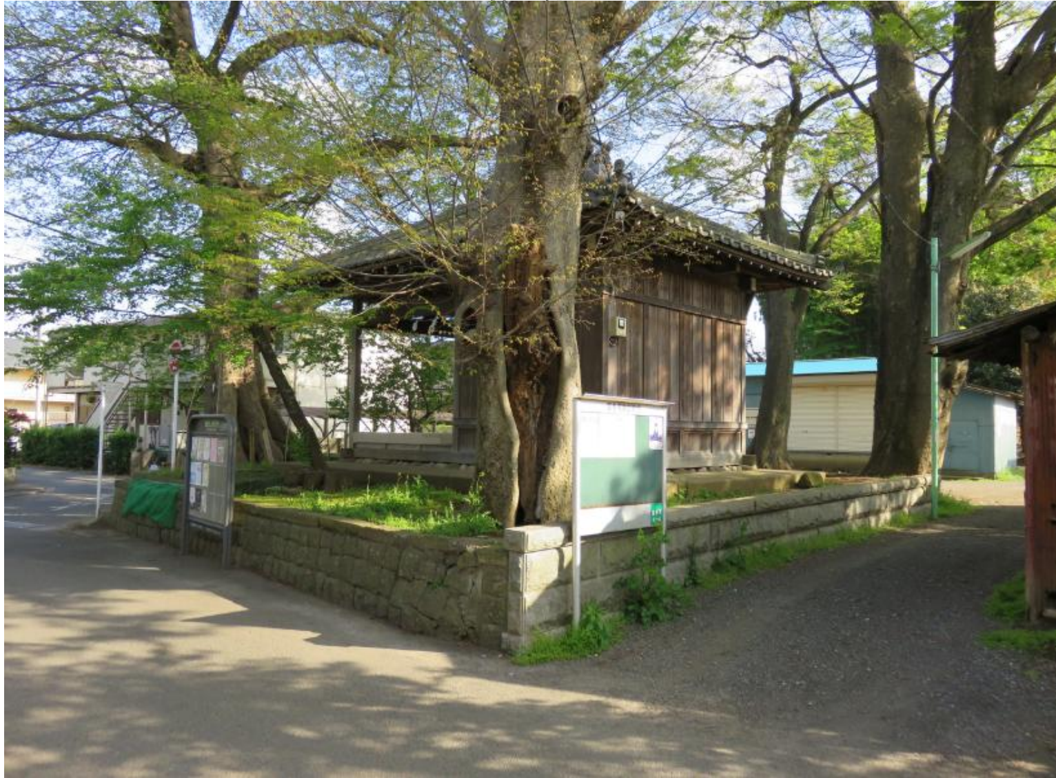
北西側から見たところ
