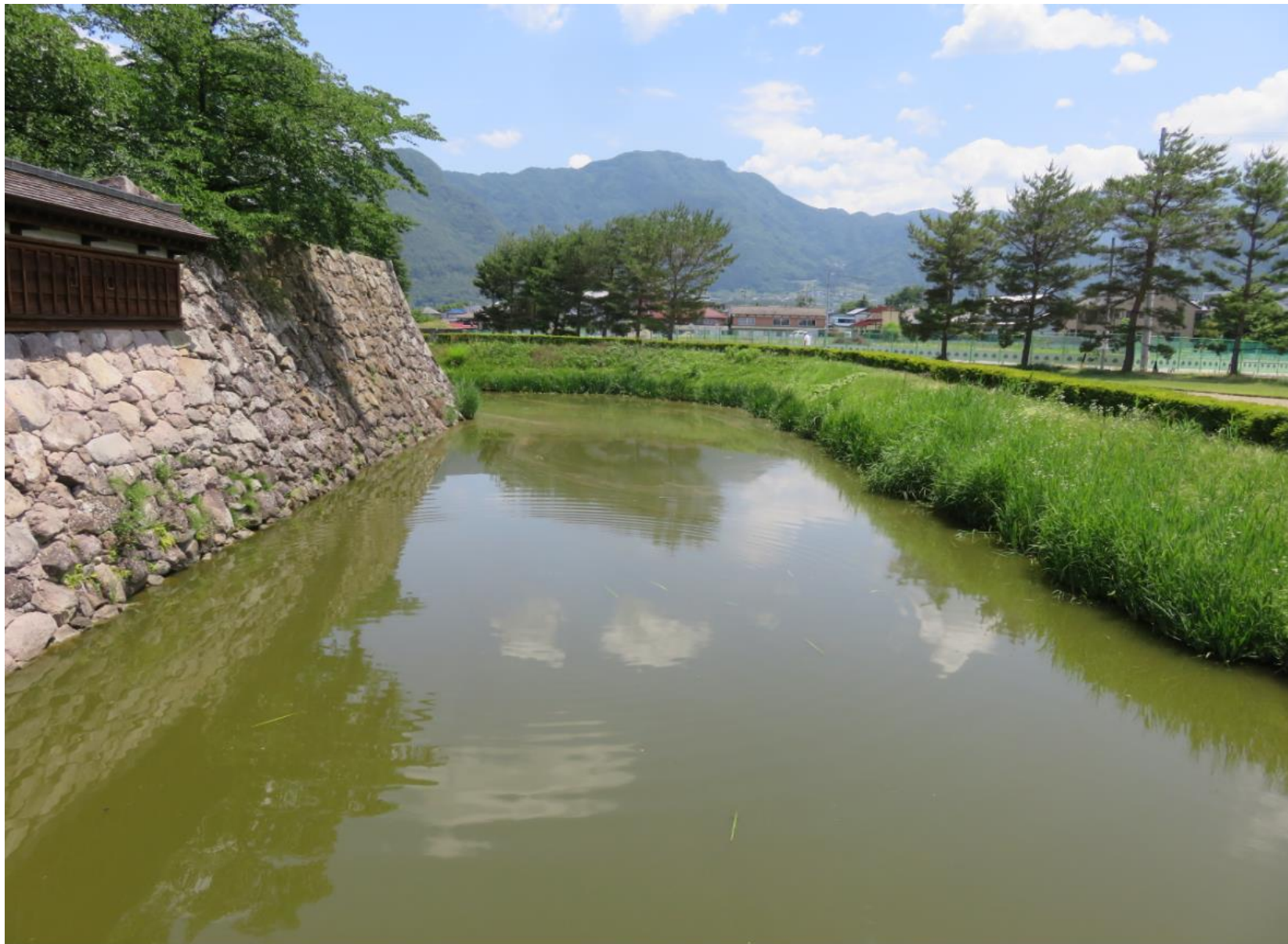
橋の上で右手を見たところ
