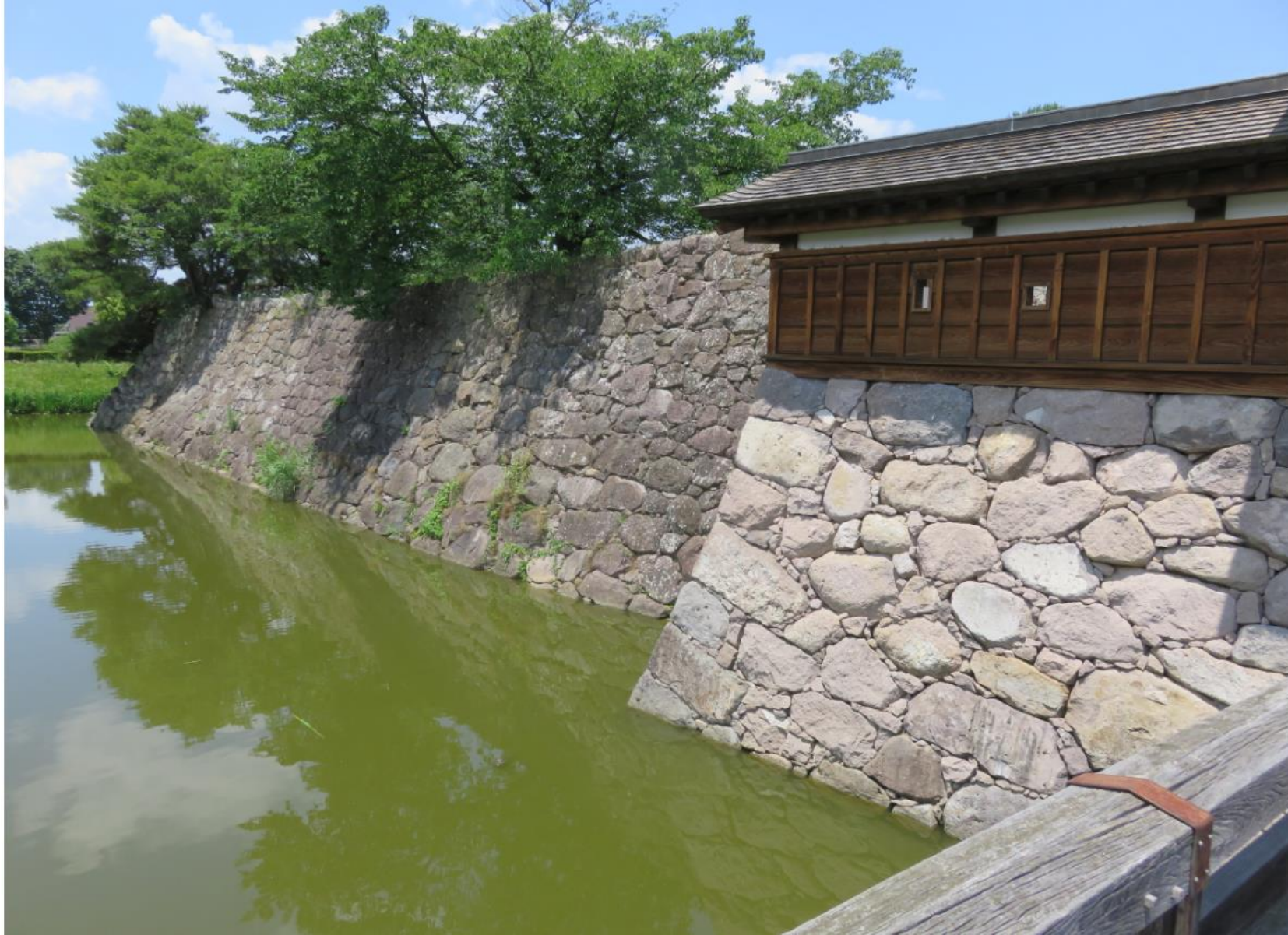
石垣を見たところ
