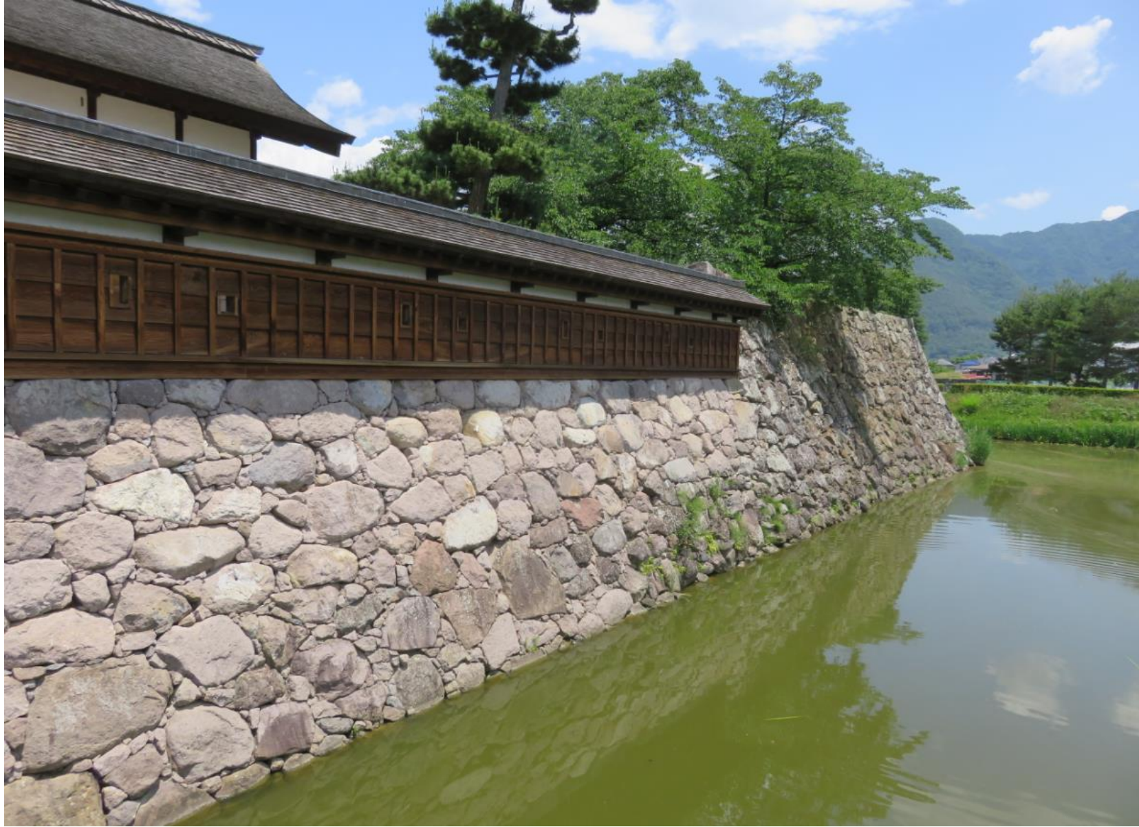
石垣を見たところ
