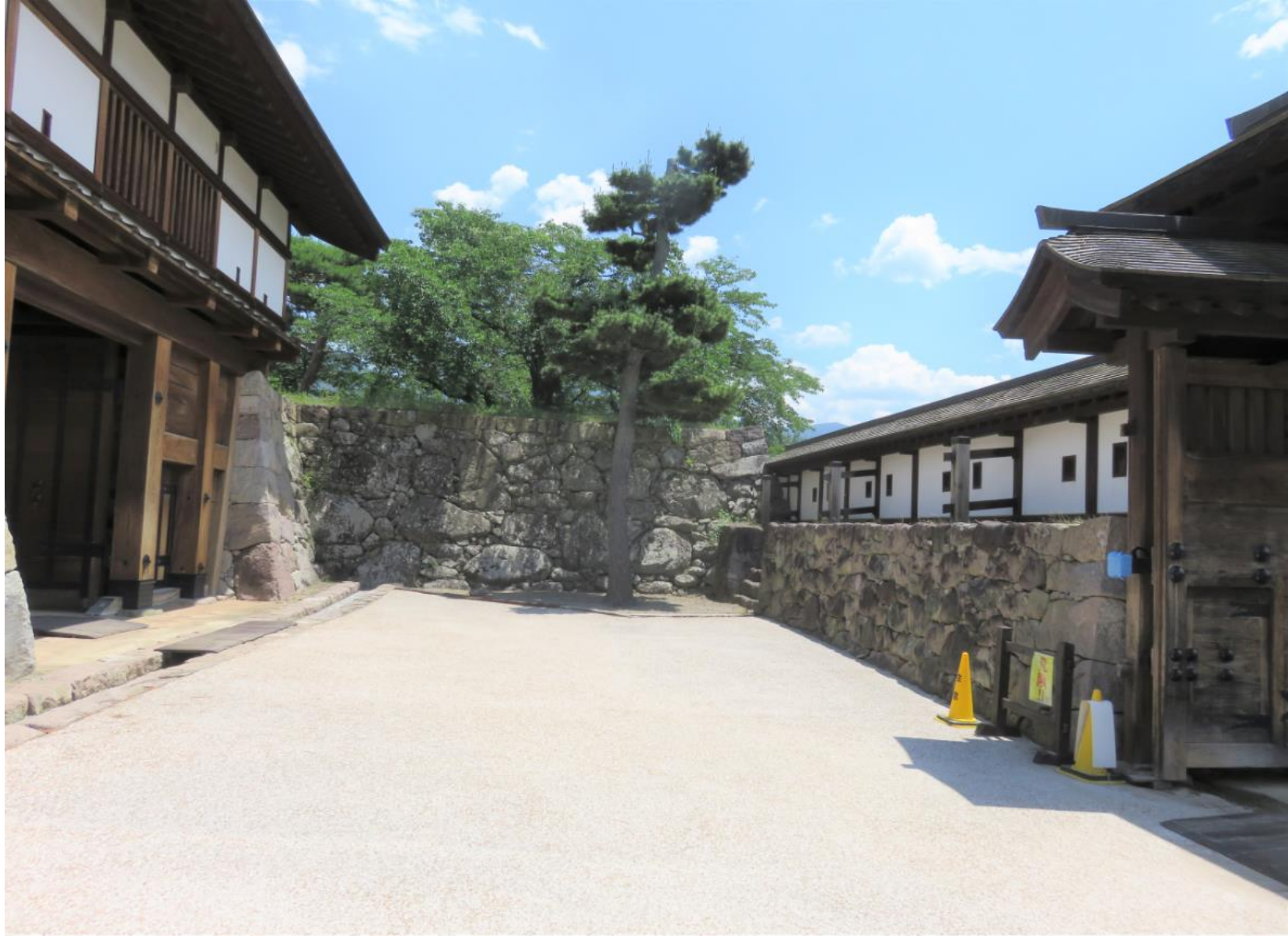
西側から東方向に柵形を見たところ/左手が櫓門（太鼓門）
