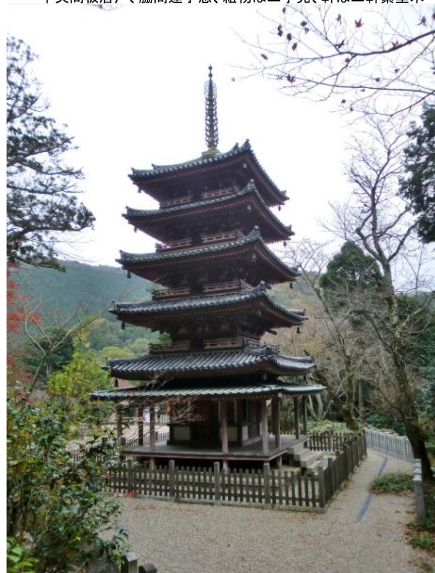
中央間板唐戸、脇間連子窓、組物は二手先、軒は二軒繁垂木
