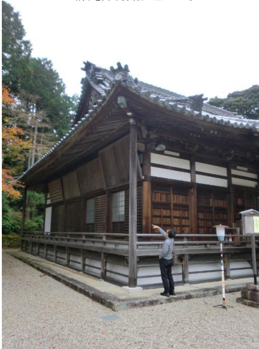
隅木を支える支柱が立っている
