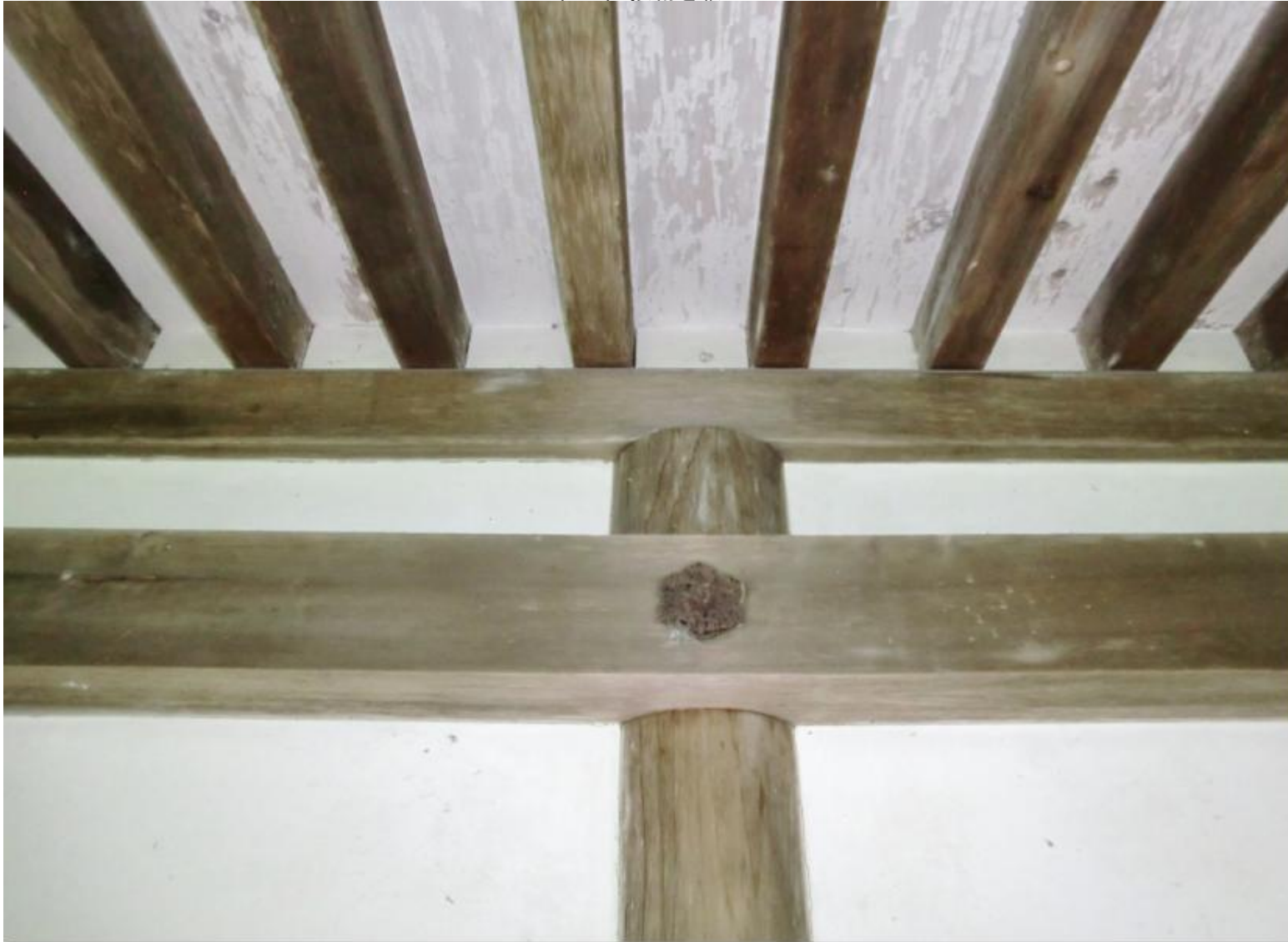
柱に直接桁を載せる
