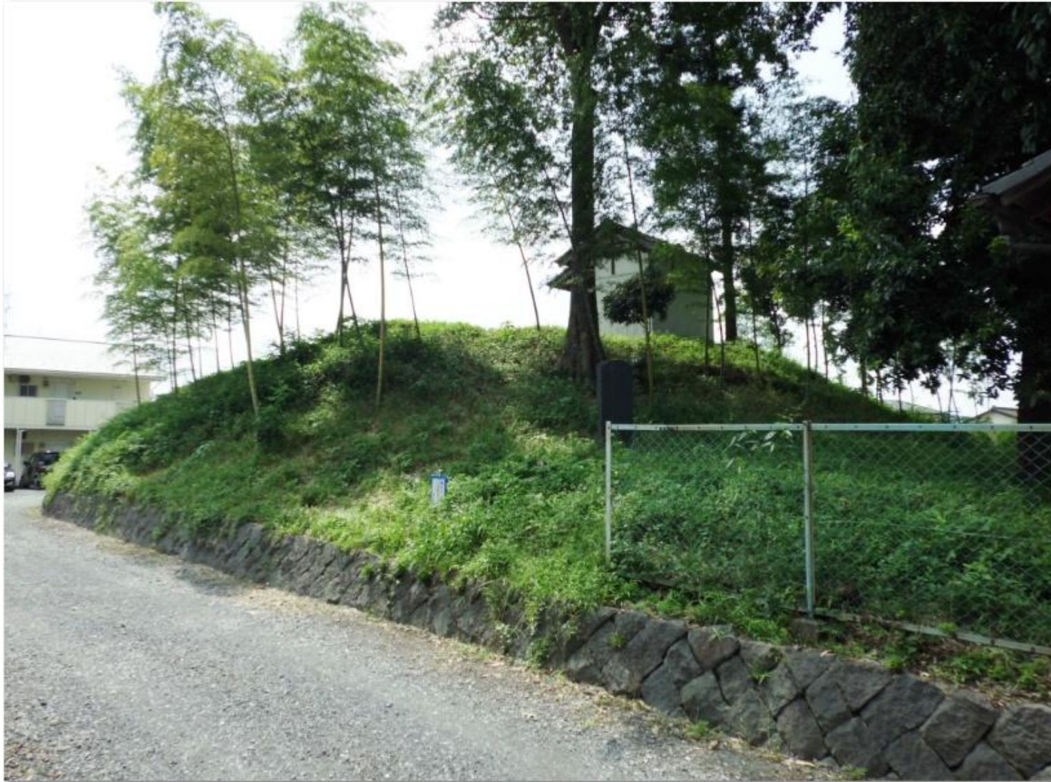
北東側から見たところ
