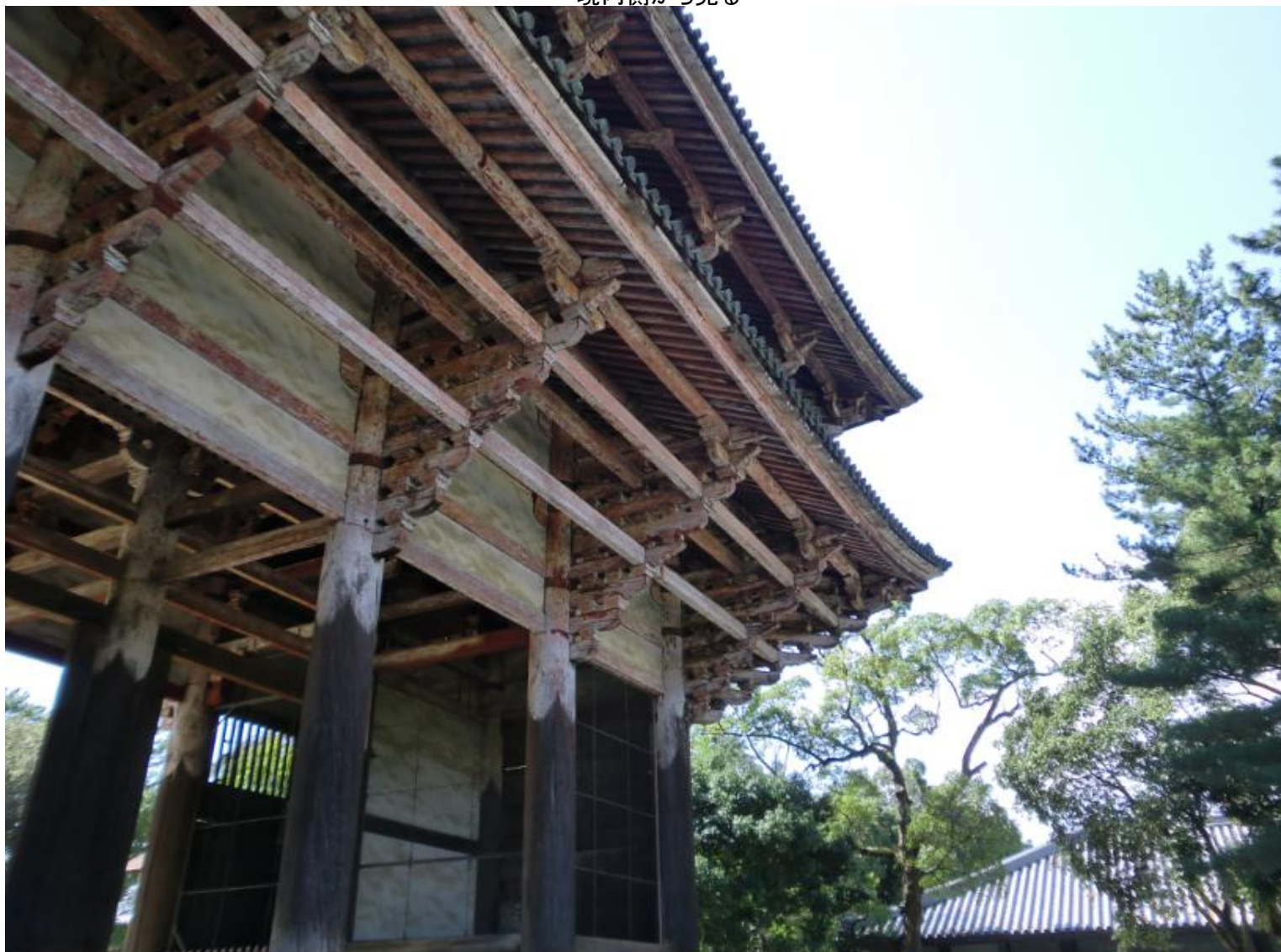
境内側から見る
