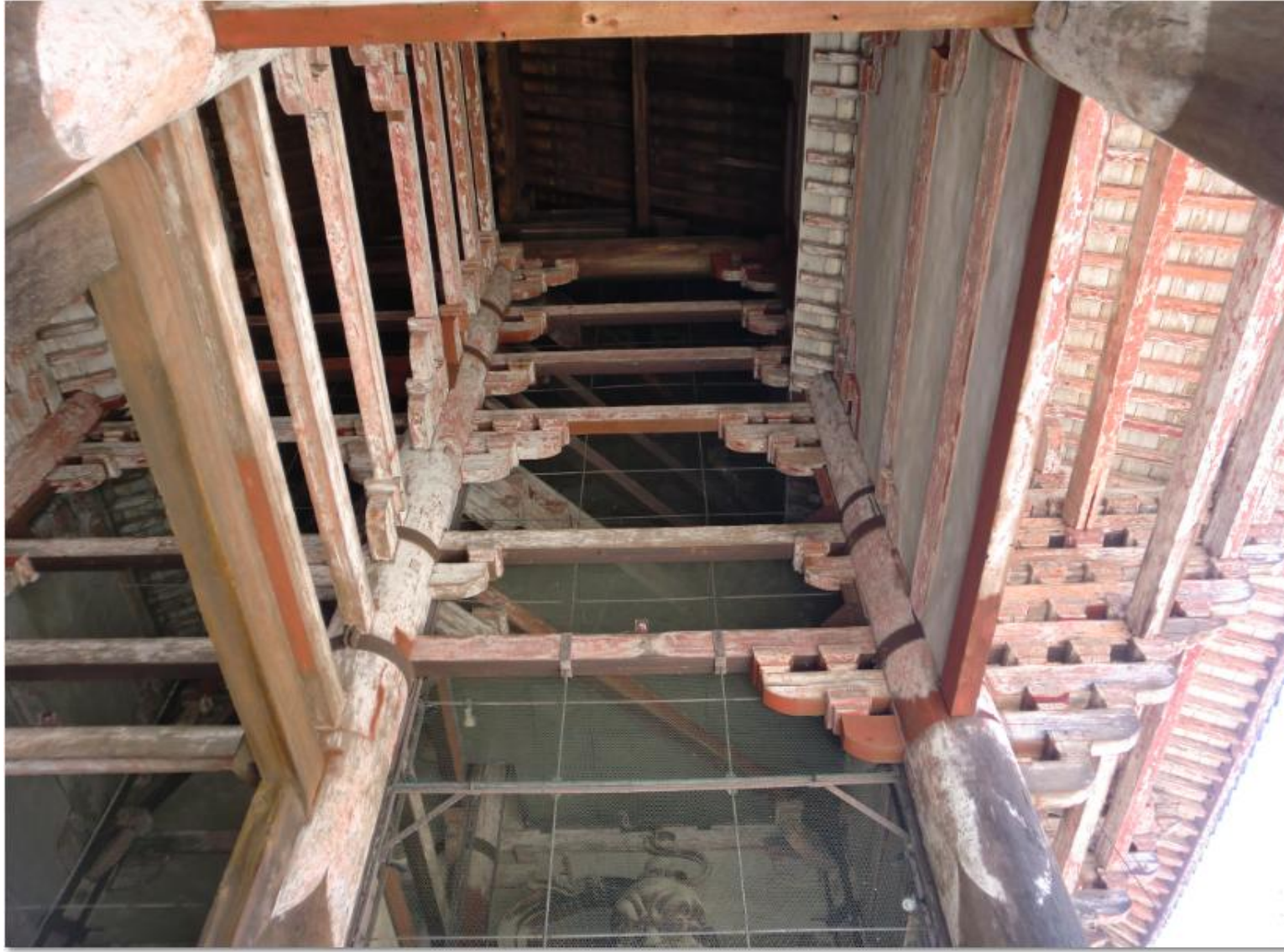
内部でも挿肘木と貫(6層)が良く分かる
