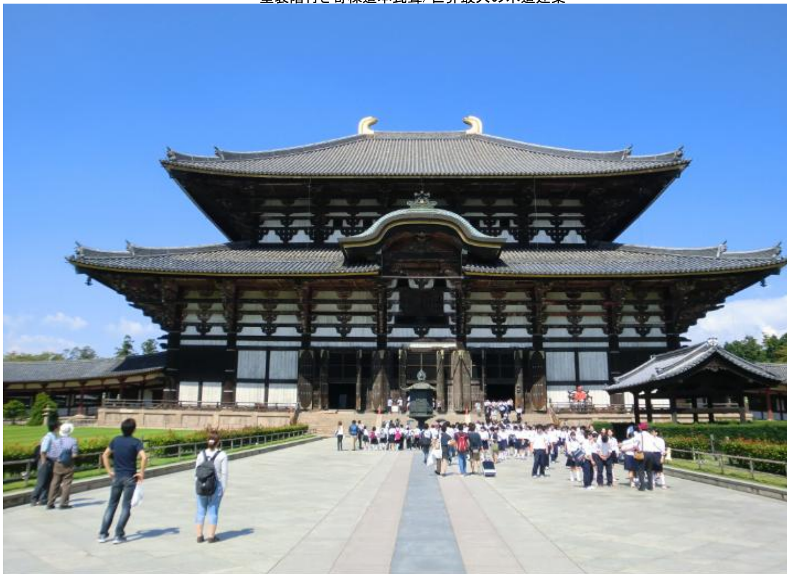
↑ 金堂正面中央手前に、現存する銅灯笼中、最古の八角灯笼(国宝)が見える
