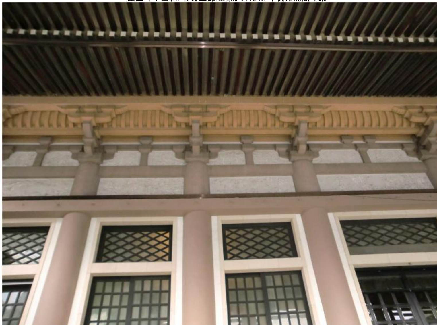
出三斗+出組/柱の上部は粽がみえる/中備えは間斗束
