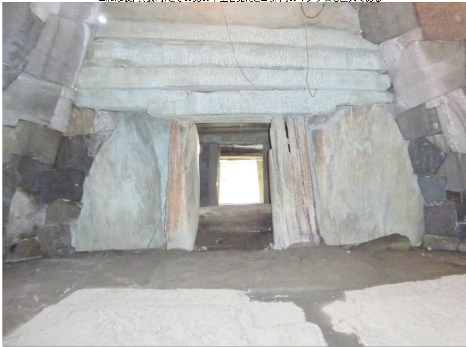
これは後門(玄門)とその先の中室を見たところ/門のマグサ石も巨大である
