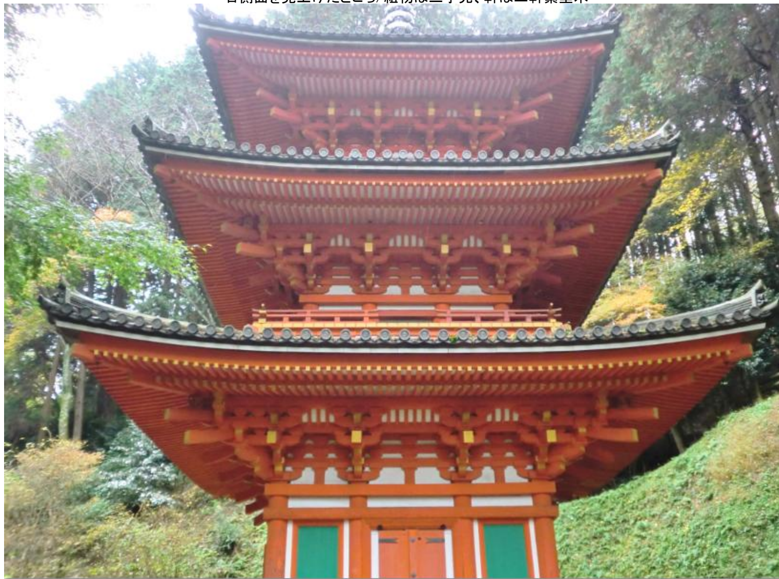
右側面を見上げたところ/組物は三手先、軒は二軒繁垂木
