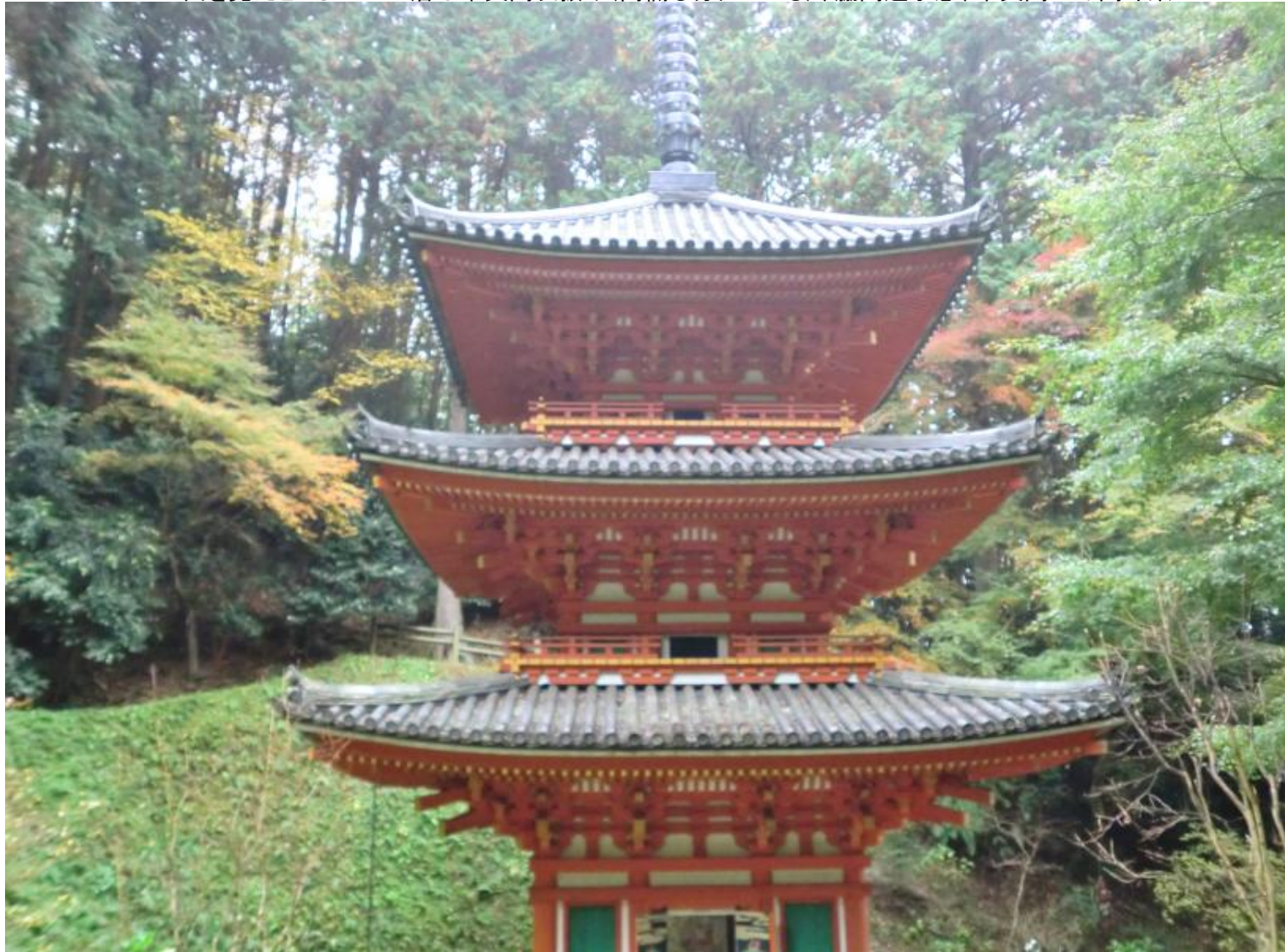
正面を見たところ/二・三層は中央間吹抜け(高欄も切れている)、脇間連子窓、中央間のみ間斗束
