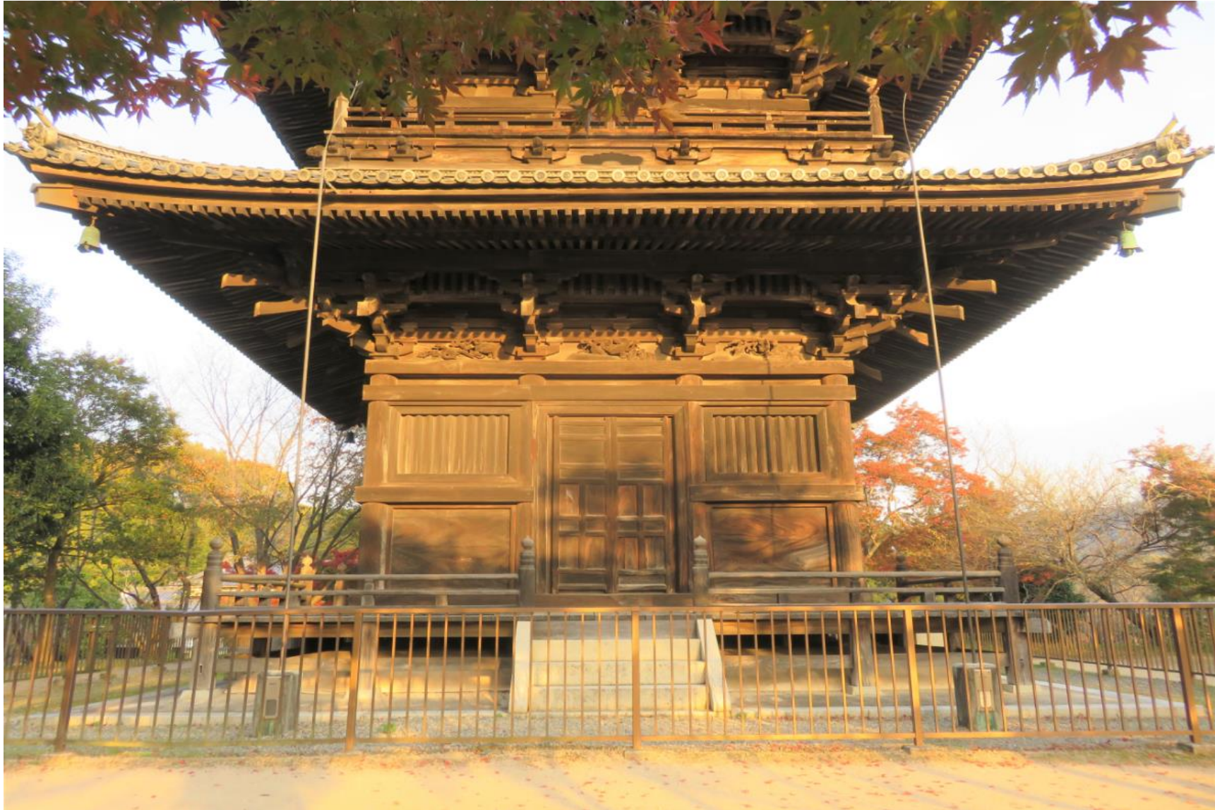
擬宝珠高欄を付した縁を巡らし、中央間棧唐戸、脇間連子窓、中備えの臺股は十二支の彫刻が嵌め込まれている
