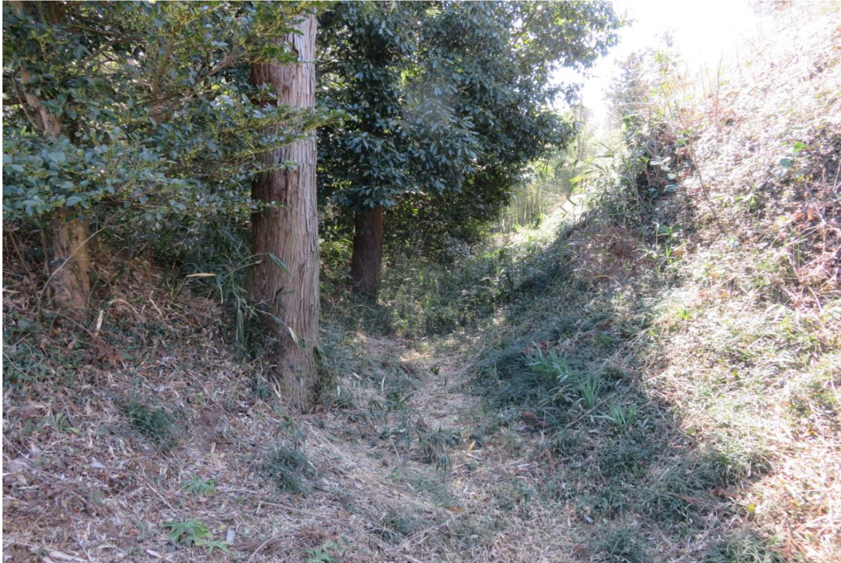
更に左手を見たところ/深い堀が回り込んでいる/左手は土塁/右上は外郭
