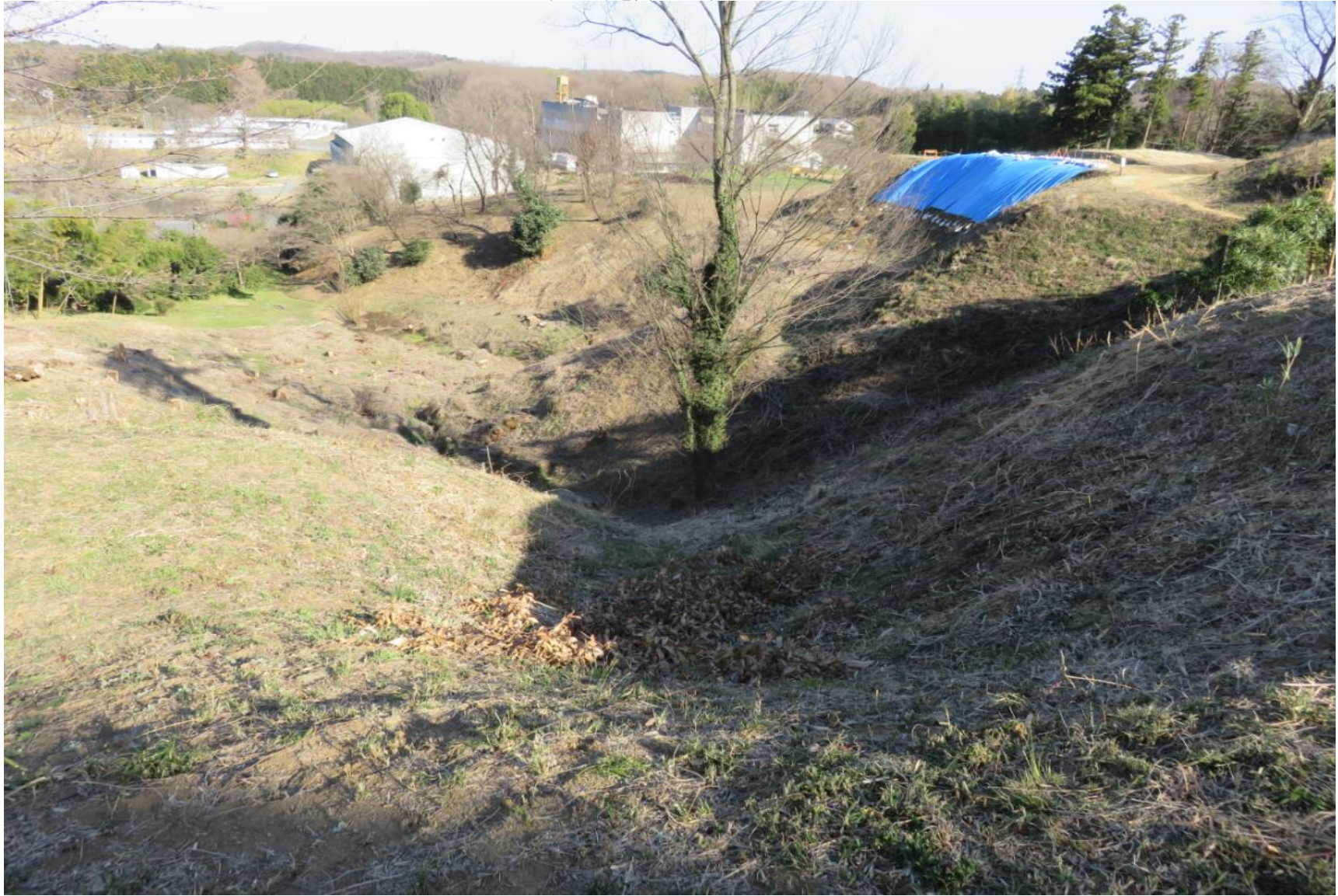
その竖堀を真上から見たところ
