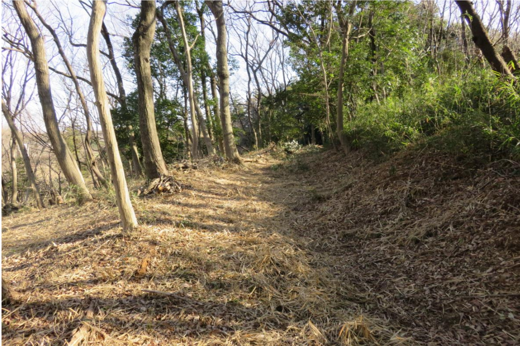
堀は更に北三の郭(右手)に沿って横堀として南方向に続いている
