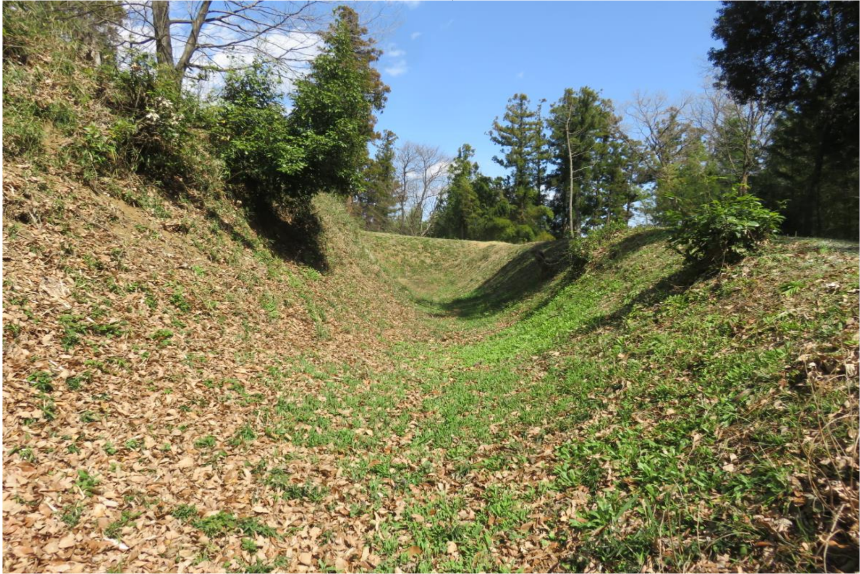
そこで堀底に下りて見たところ
