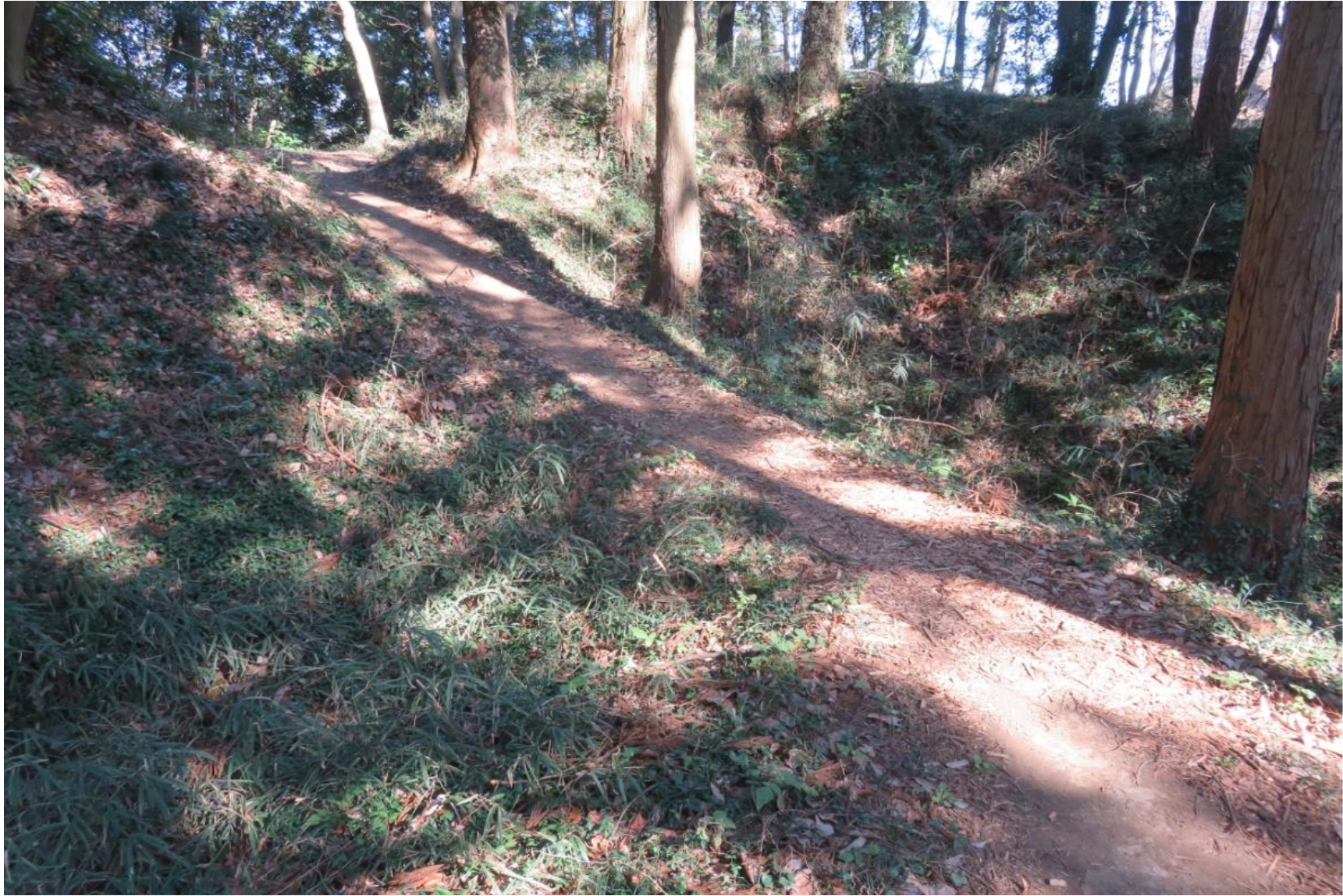
土橋をアップで見るところ
