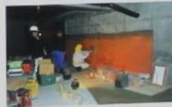
⑥ 展示工事 展示室に色々な仕掛けをこしらえて、完成!
