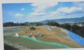
④ 盛土工事 墳丘を元の形に復元します。 展示室もかきました。
