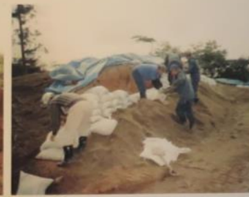
断面を土のうと砂で保護する作業
