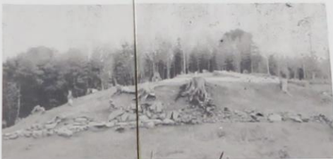
発掘調査時の貼石の様子（西から）
