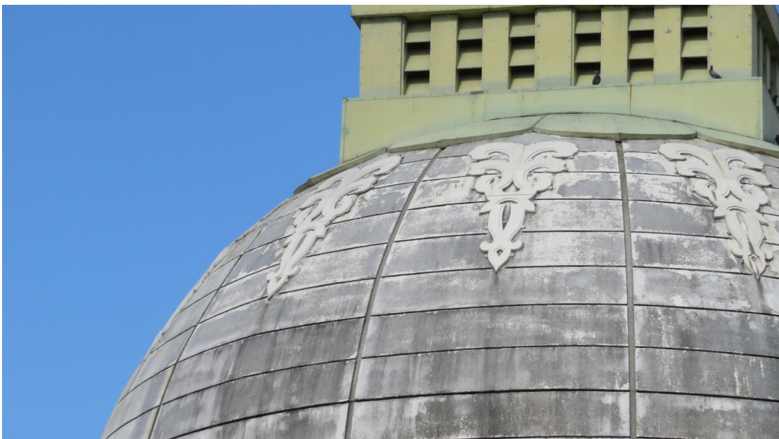
これは中央大塔のドームの上部を見たところ
