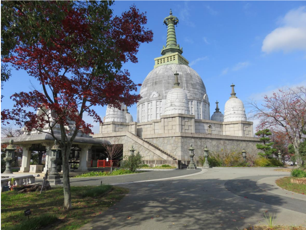
右手から見たところ/二重基壇となっており、基壇の壁面にはモザイク状のデザインが施されている/ video
