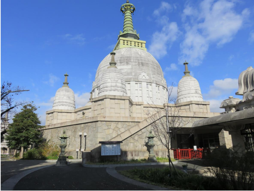
左手から見たところ/中央大塔の周りに六つの小塔が取り付く/ video
