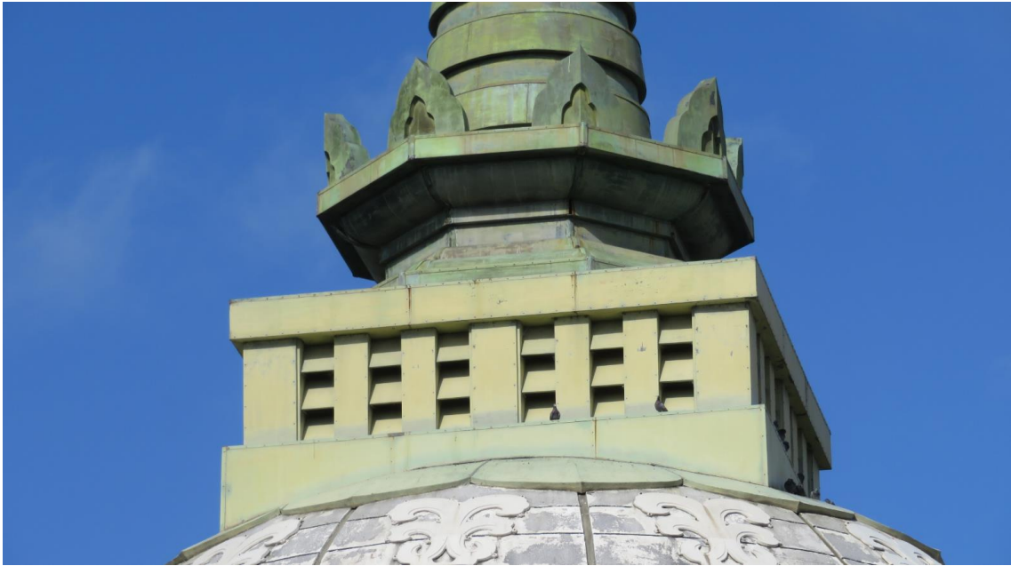
その上部の露盤・伏鉢・請花
