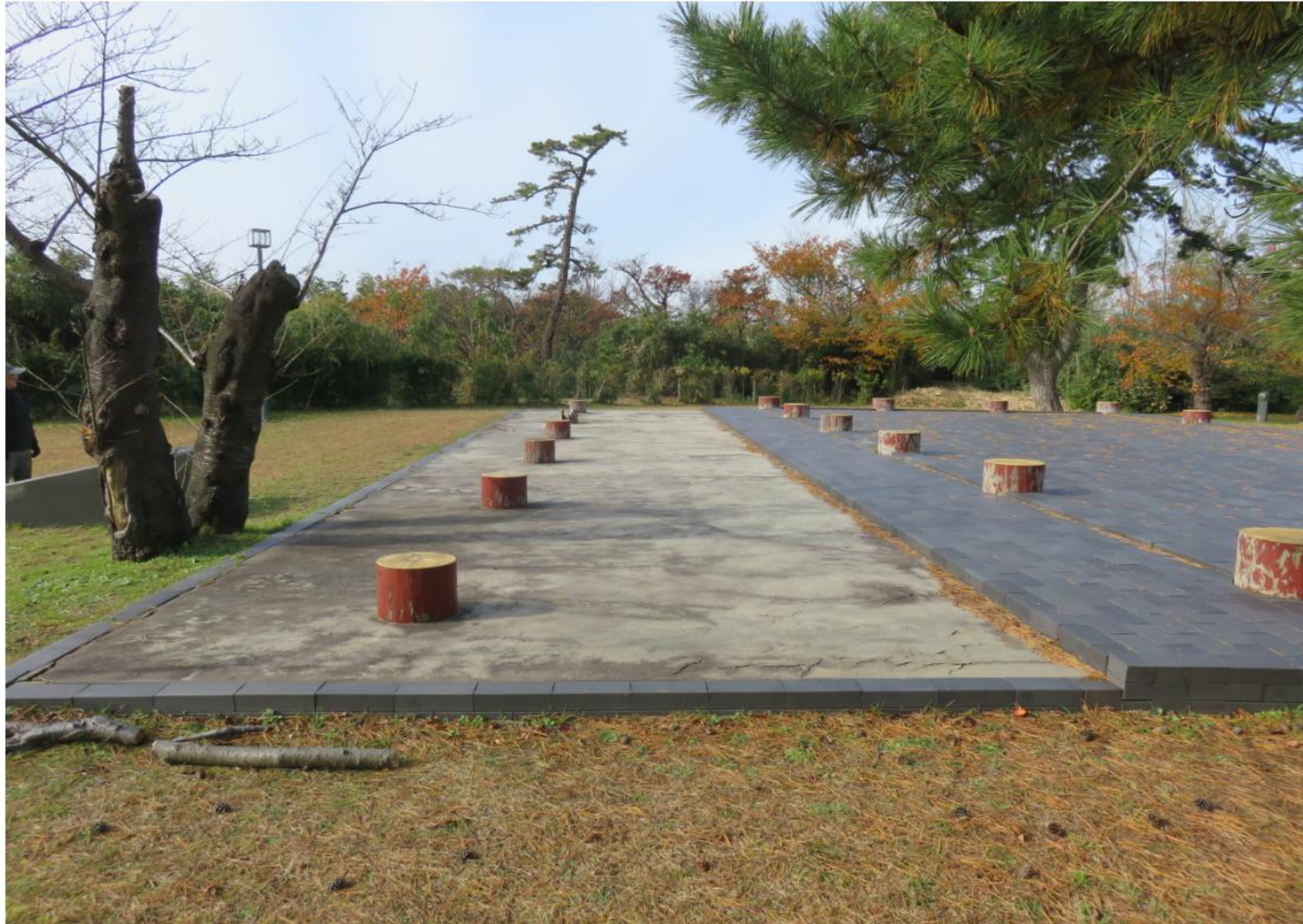
東側から底部分を見たところ
