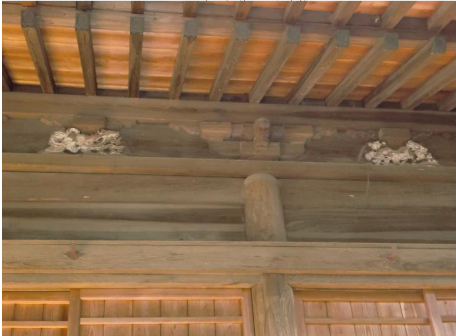
柱上部の粽と平三斗の組物
