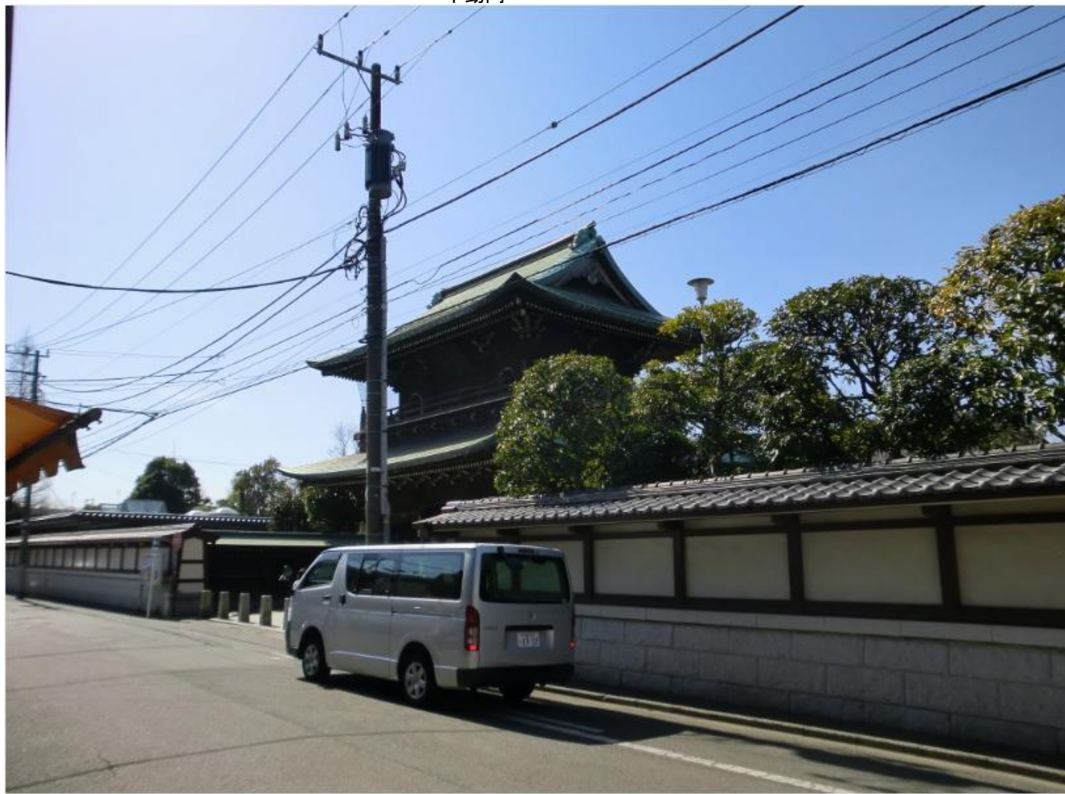
昭和50年に移築に伴い外装屋根の改修を大岡實建築研究所の手で行なっている。付属の透塀も新設した。
