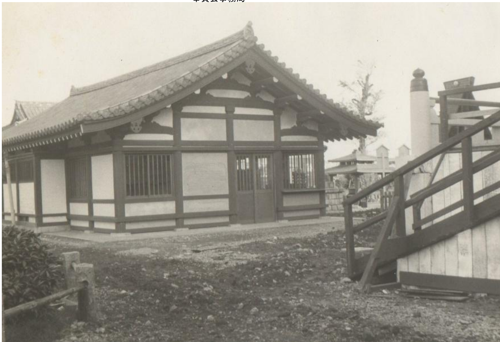
昭和38.10(1963)～39.05に助手の松浦弘二が意匠設計共、木造で建立した。構造設計は松浦弘二、施工は大林組であった。しかしその後境内再整備に伴い、解体された。
