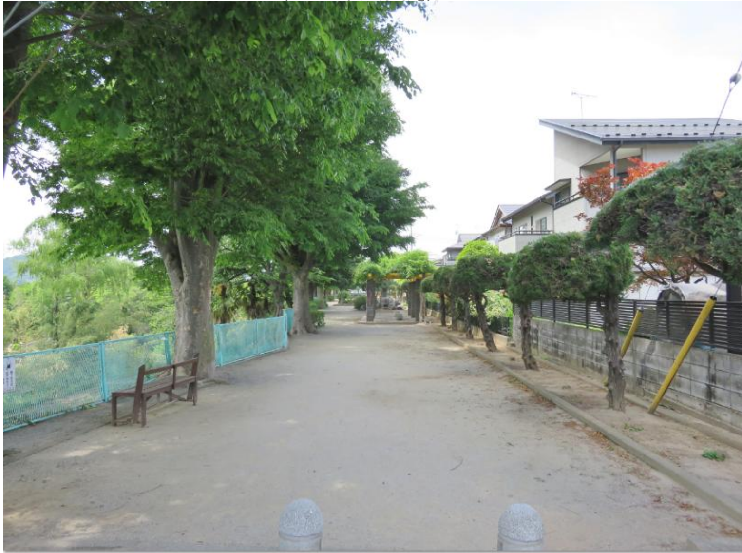
そこから右手(西方向)を見たところ
