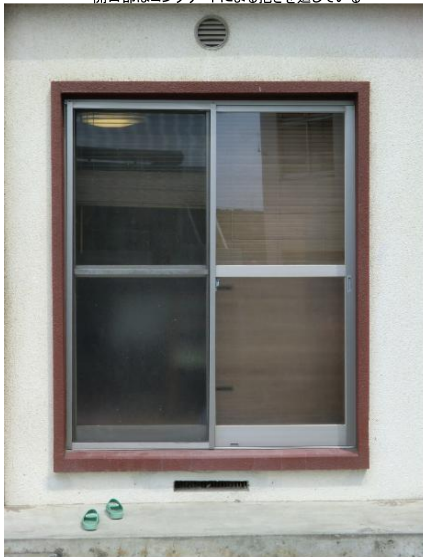
開口部はコンクリートによる抱きを廻している
