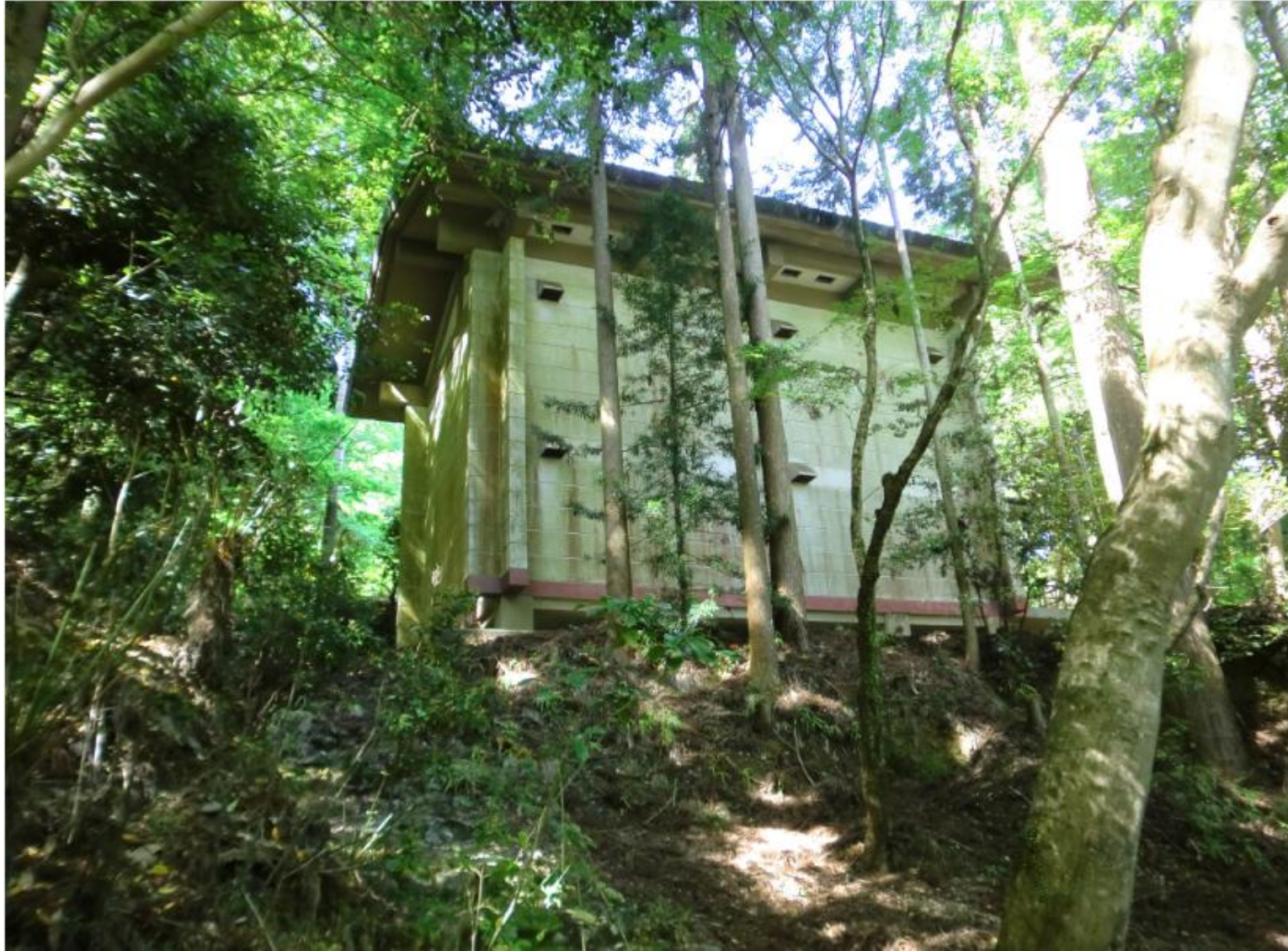
南面を斜面下から見上げる
