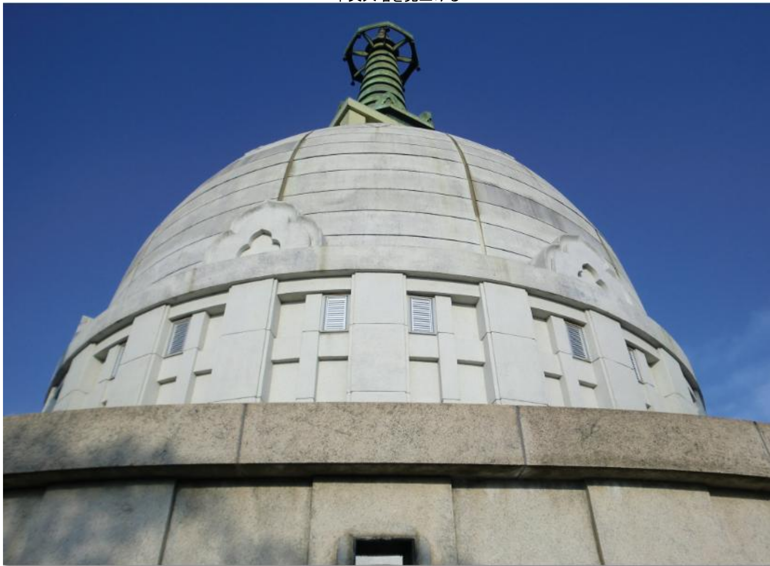
中央大塔を見上げる
