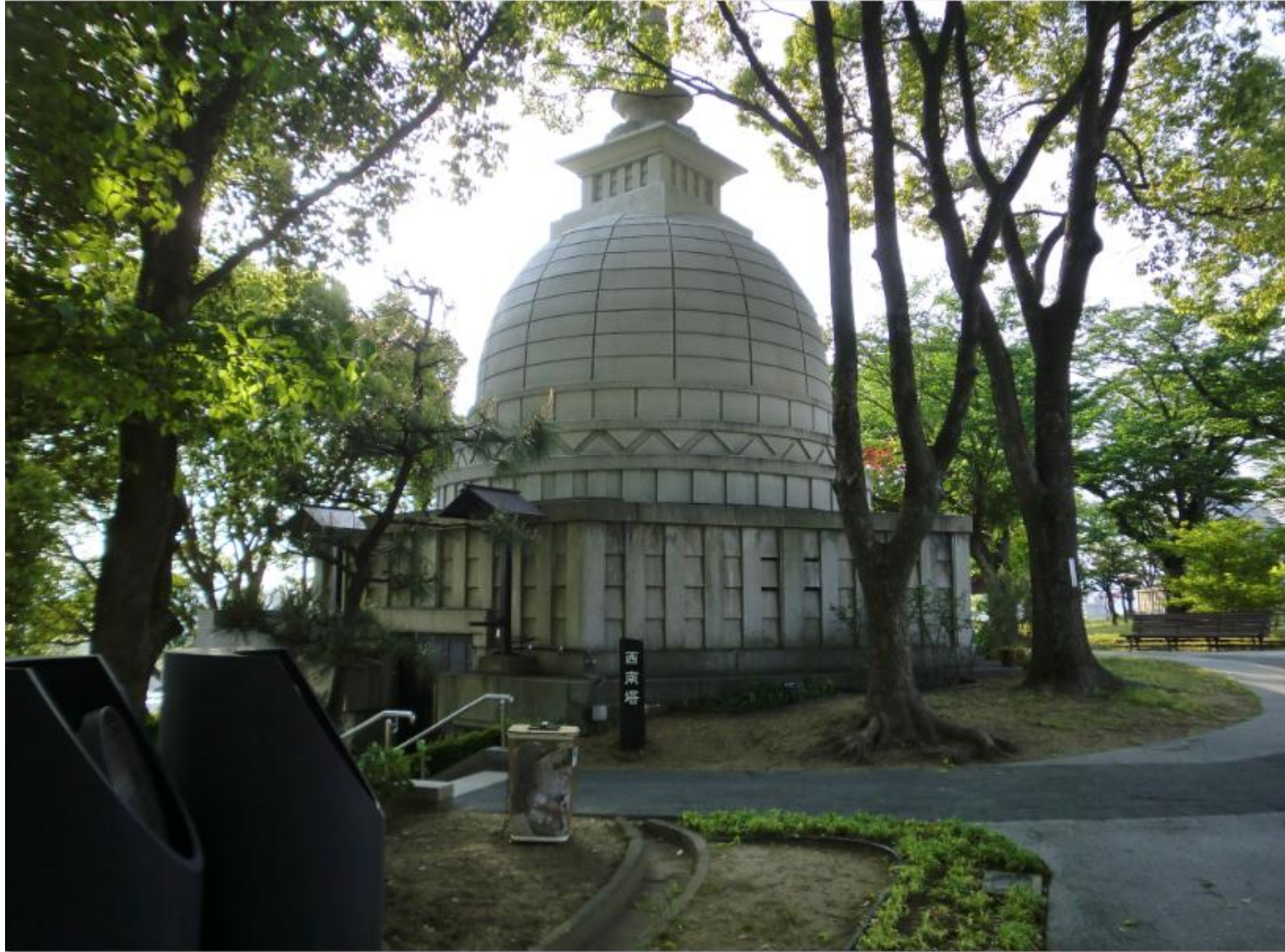
「西南塔」/左下が斜面となっており、ほかの三つの隅塔と平面(入口の位置)が違う
