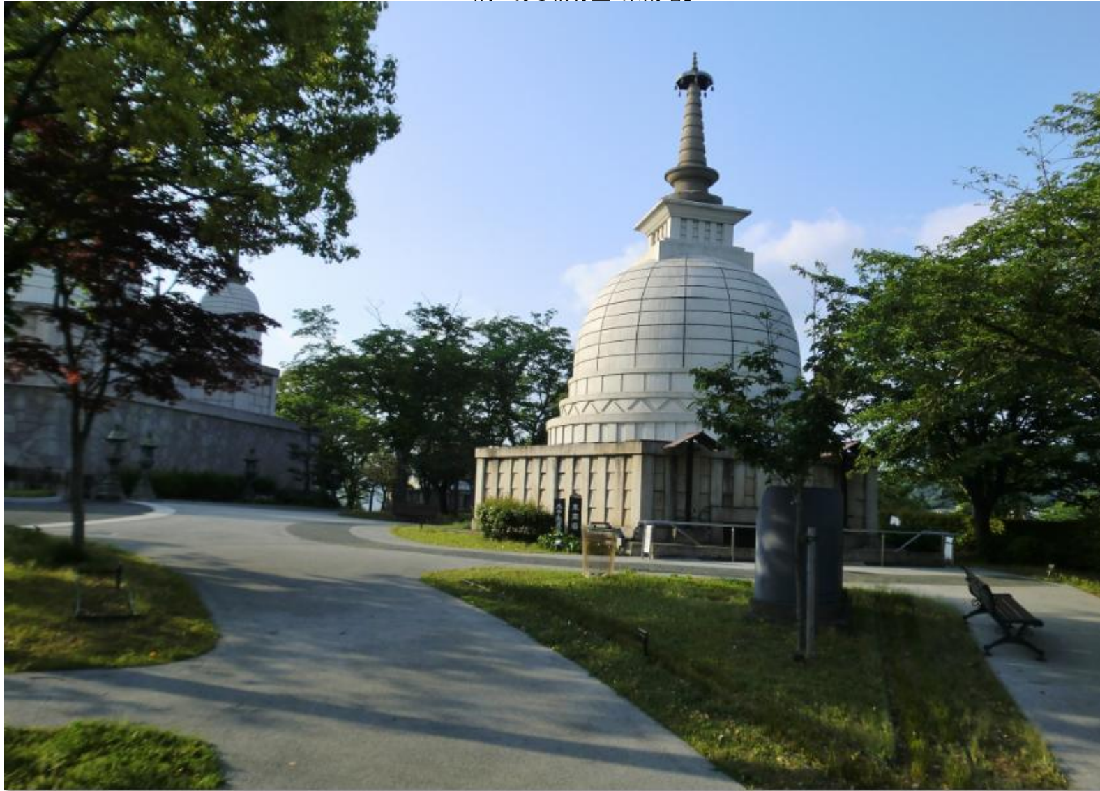
四隅にある納骨堂「東南塔」
