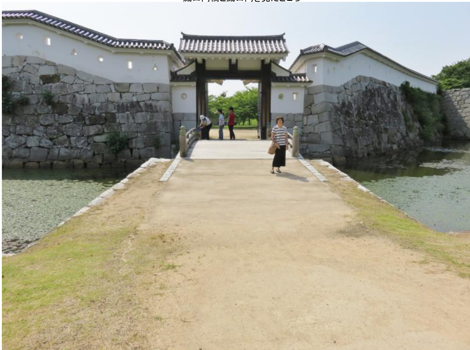
厩口門橋と厩口門を見たところ
