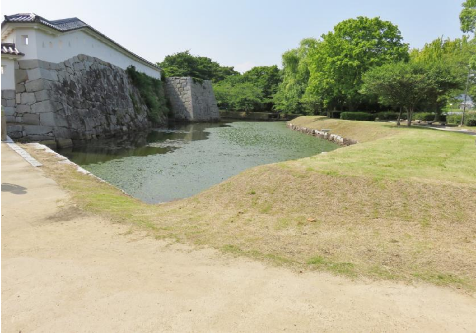
同じく右手を見たところ/東北隅櫓台が見える
