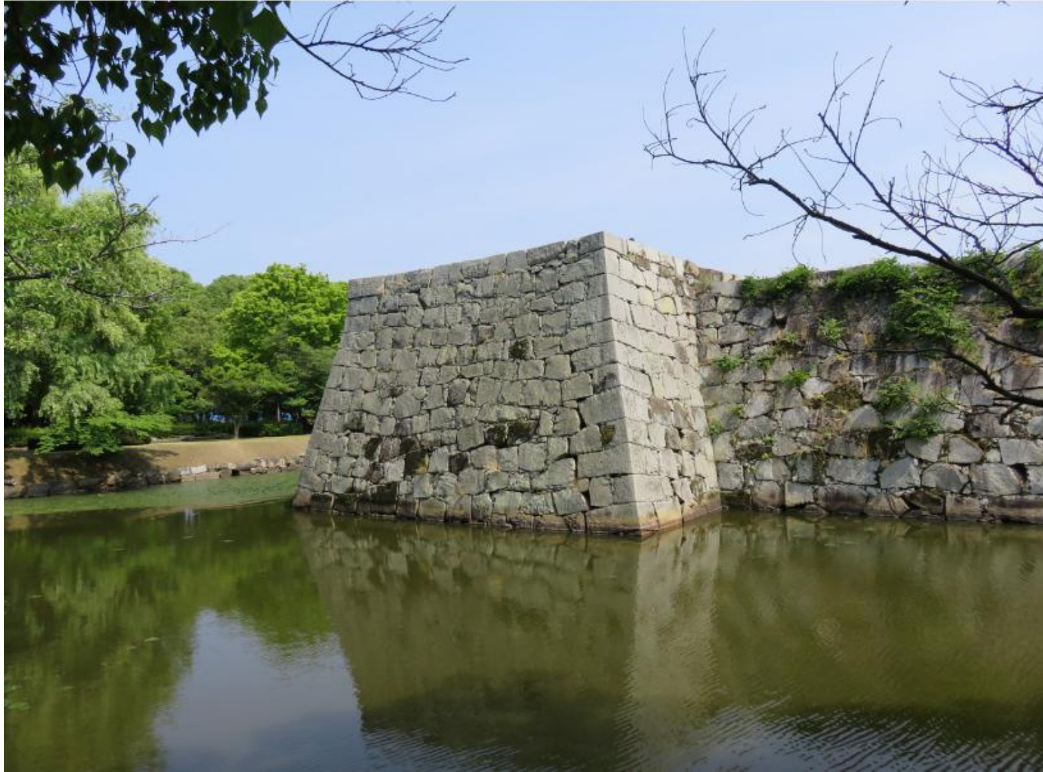
東北隅櫓台/ここだけに隅櫓が築かれた(他は横矢櫓形となっている)
