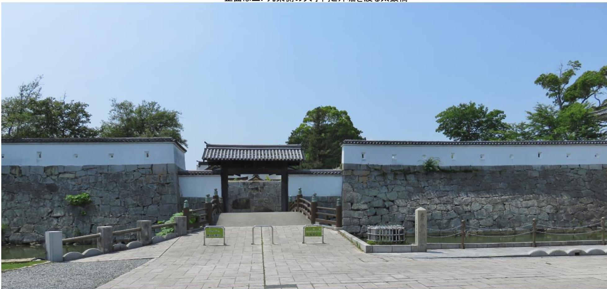
正面は三ノ丸東側の大手門と外堀を渡る太鼓橋
