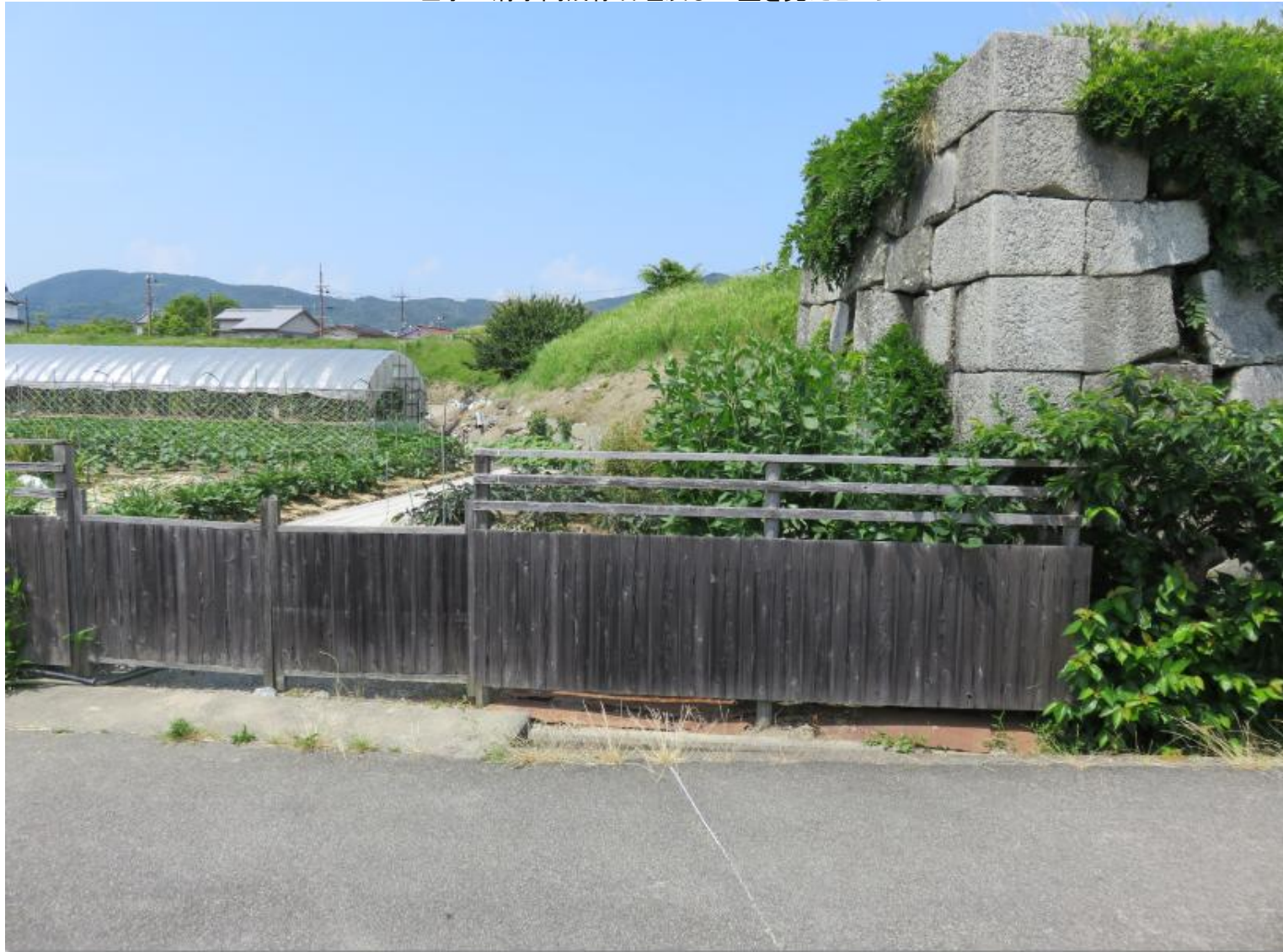
左手の清水門残存石垣及び土塁を見たところ
