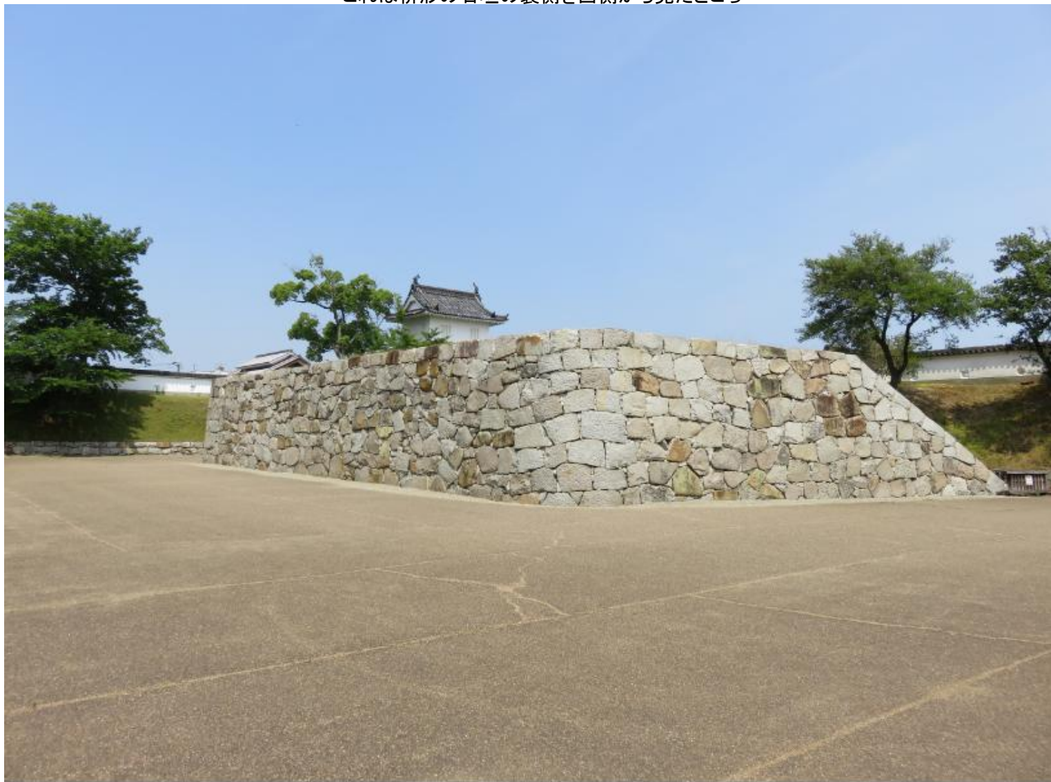
これは枡形の石垣の裏側を西側から見たところ
