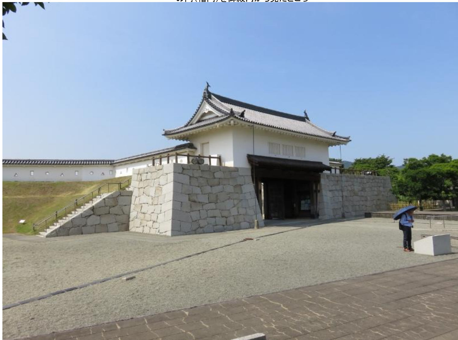
一の門(櫓門)を御殿内から見たところ
