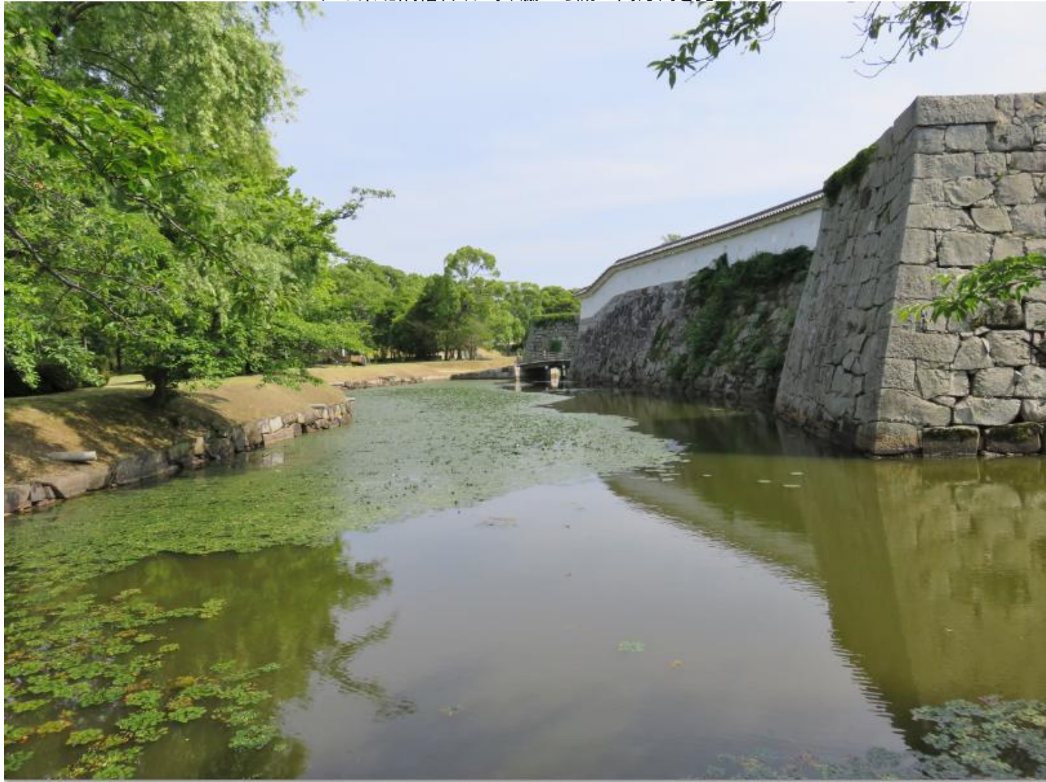
これは東北隅櫓台(右手)脇から既口門方向を見たところ
