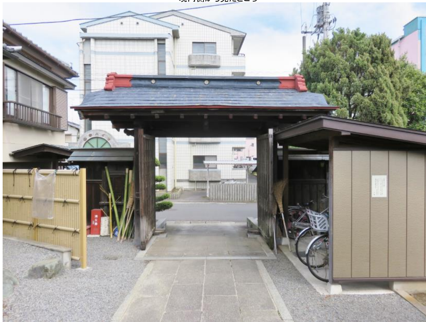
境内側から見たところ
