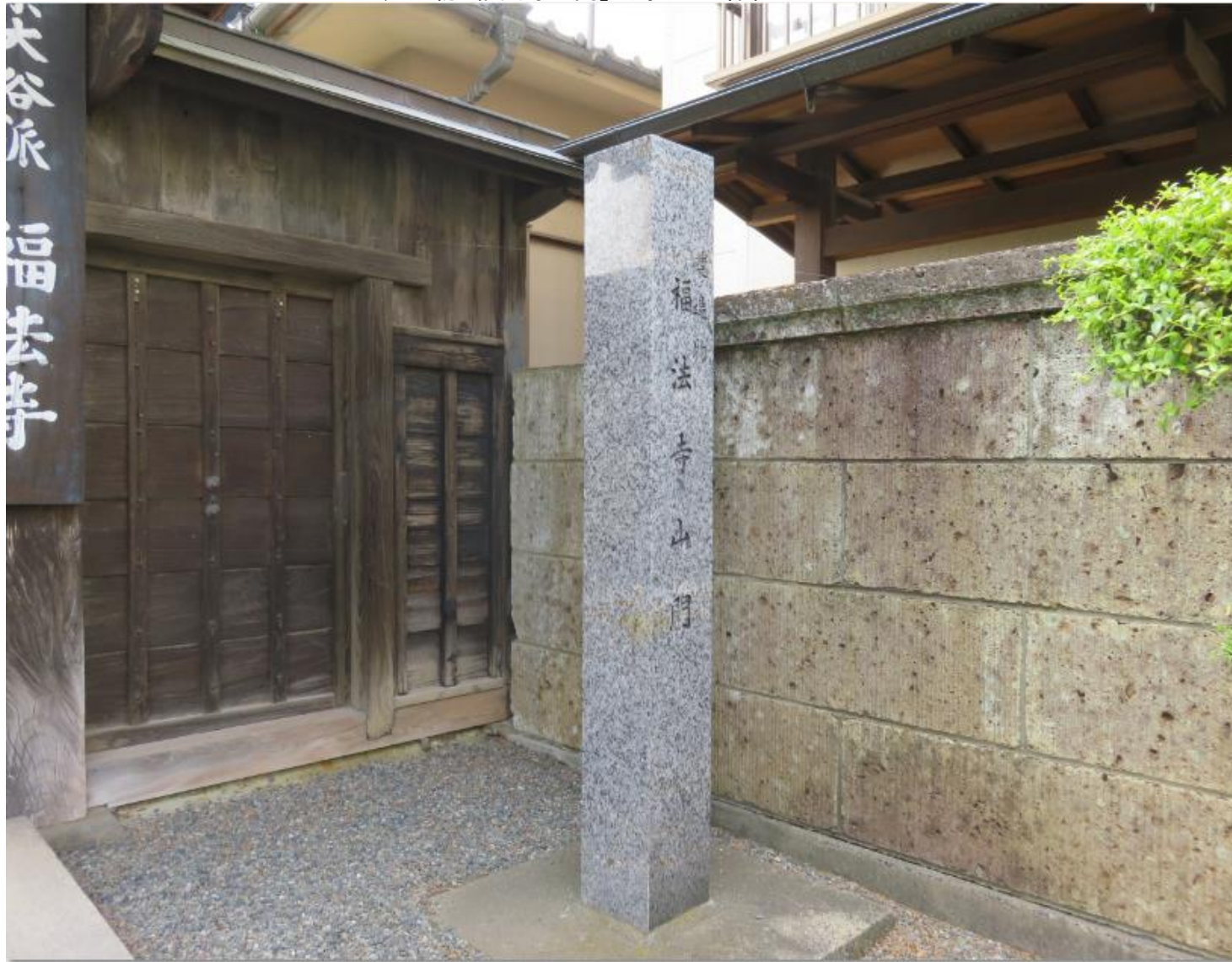
「建造物 福法寺山門」と刻まれた標柱が立っている
