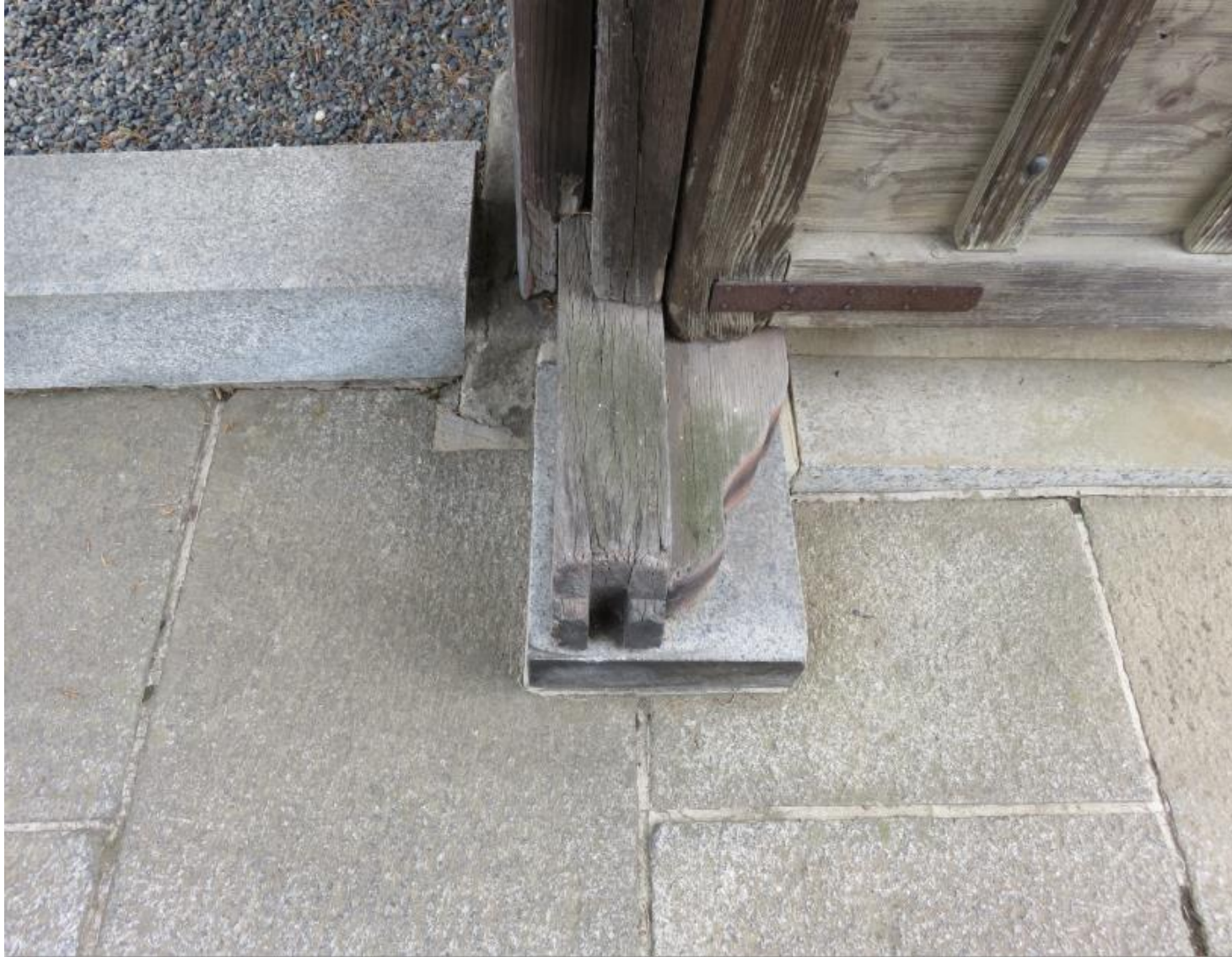
柱足元のヒンジを見たところ
