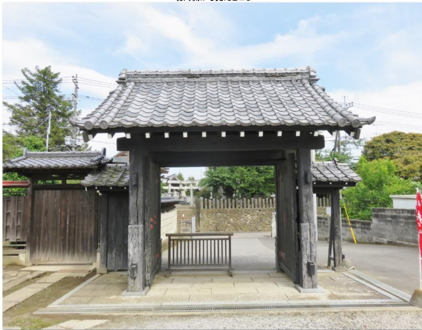
境内側から見たところ
