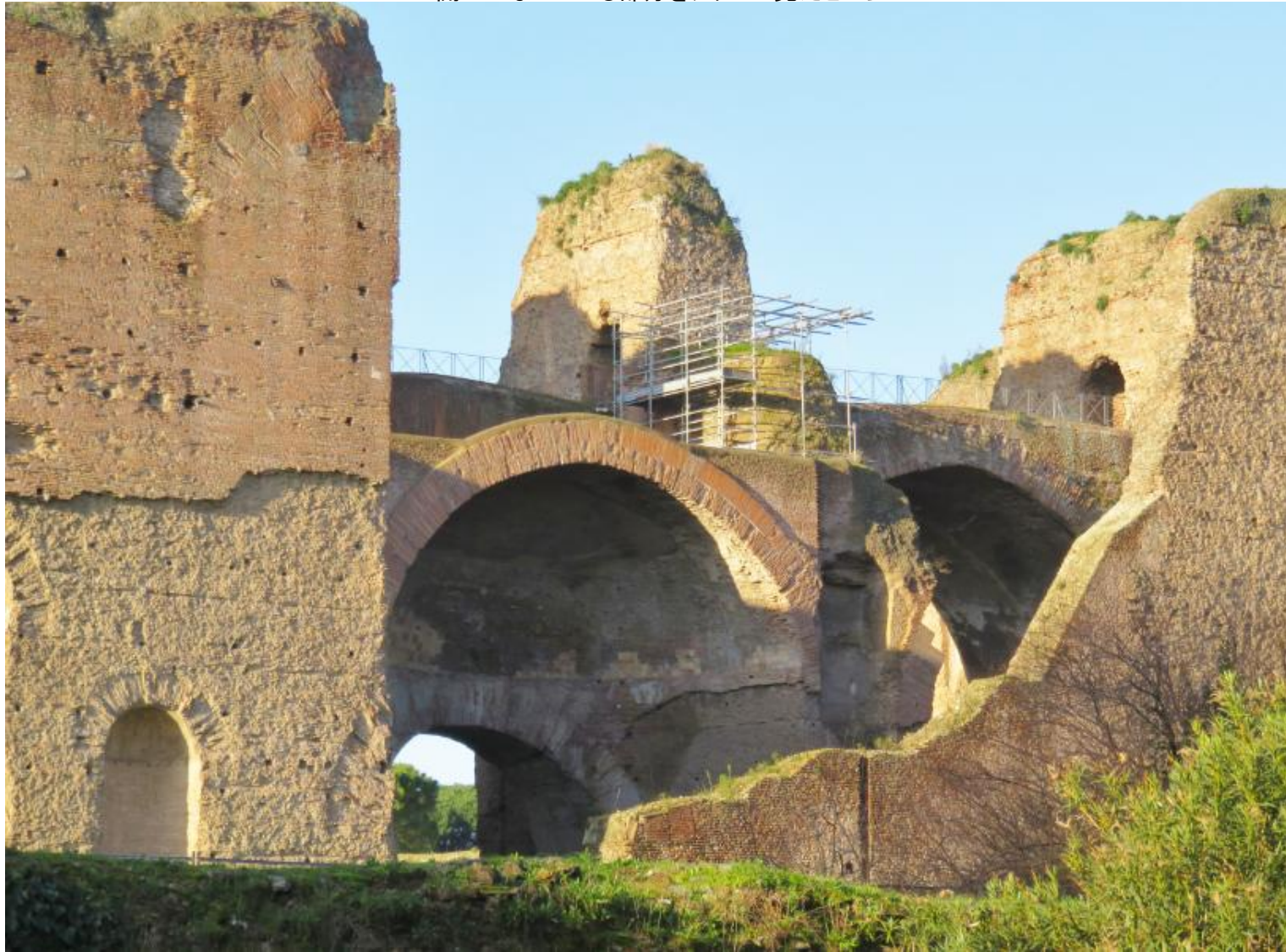
開口になっている部分をアップで見たところ
