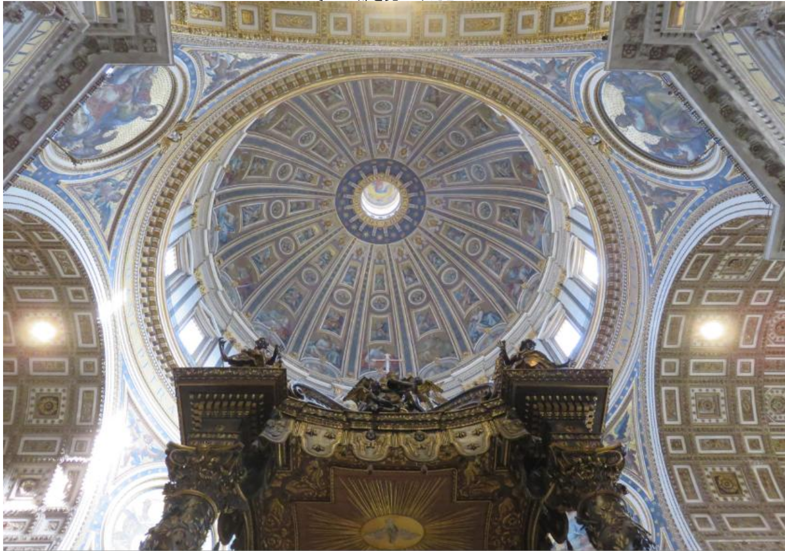
その上部を見上げたところ
