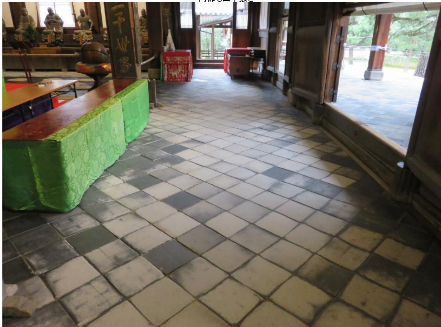
内部も四半敷き
