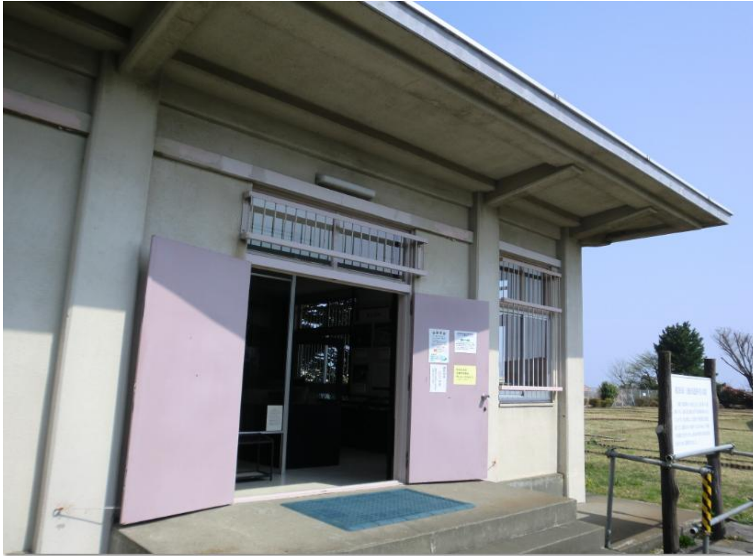
室内の床レベルが入り口のタタキのレベルより低いのはどうしたことか
