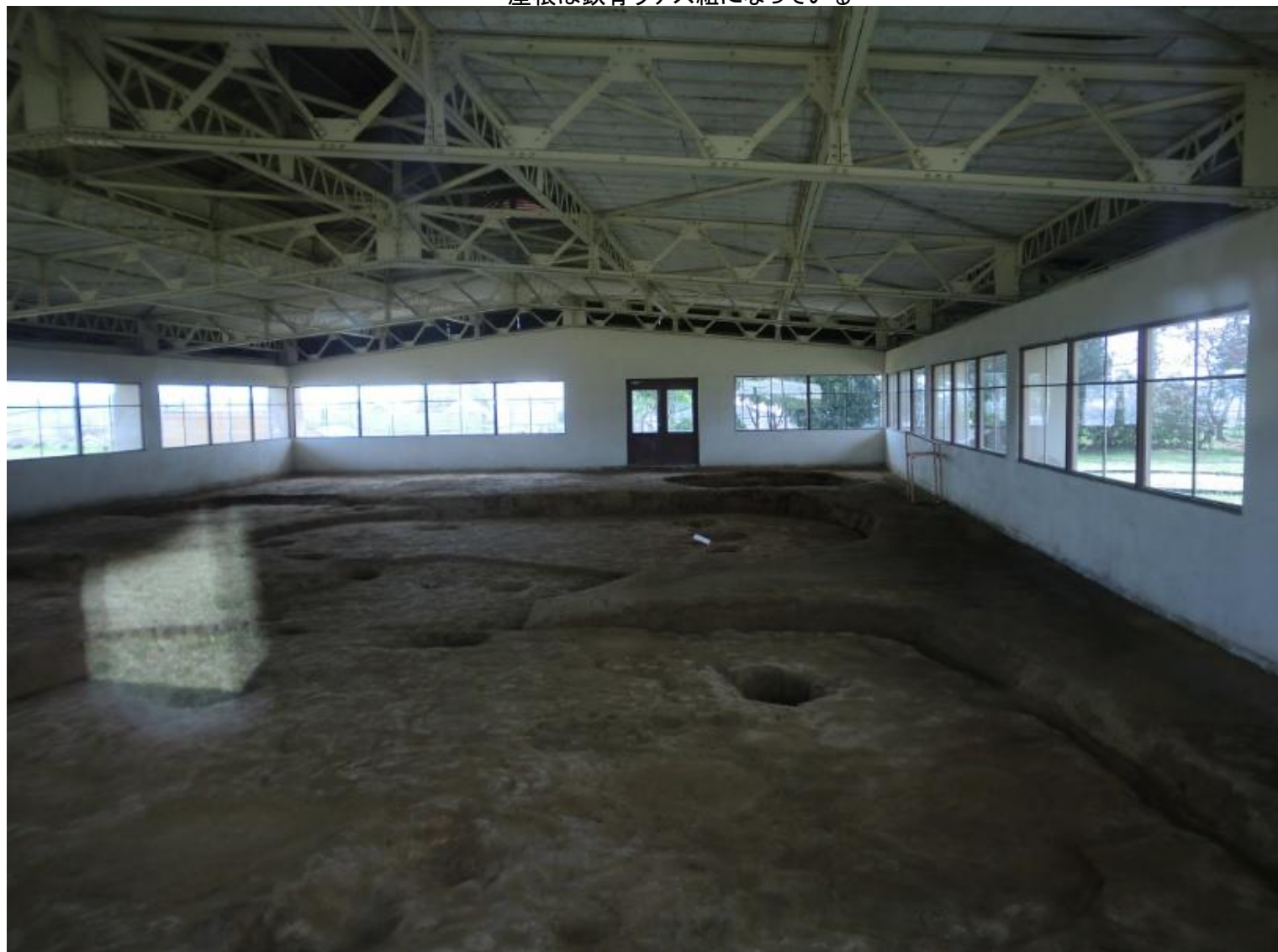
屋根は鉄骨ラチス組になっている
